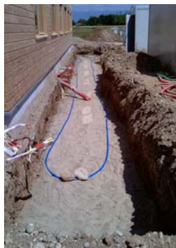
Réseau enterré du puits canadien hydraulique
