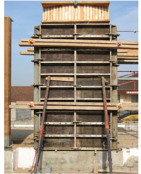
Coffrage des trumeaux
