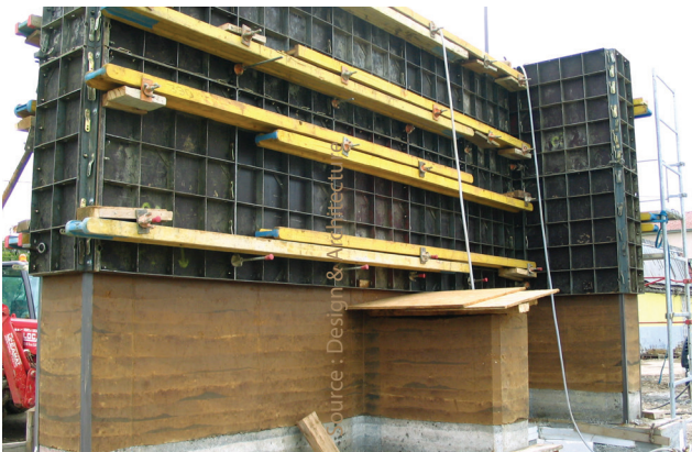
Mise en place du mur pisé en strate
