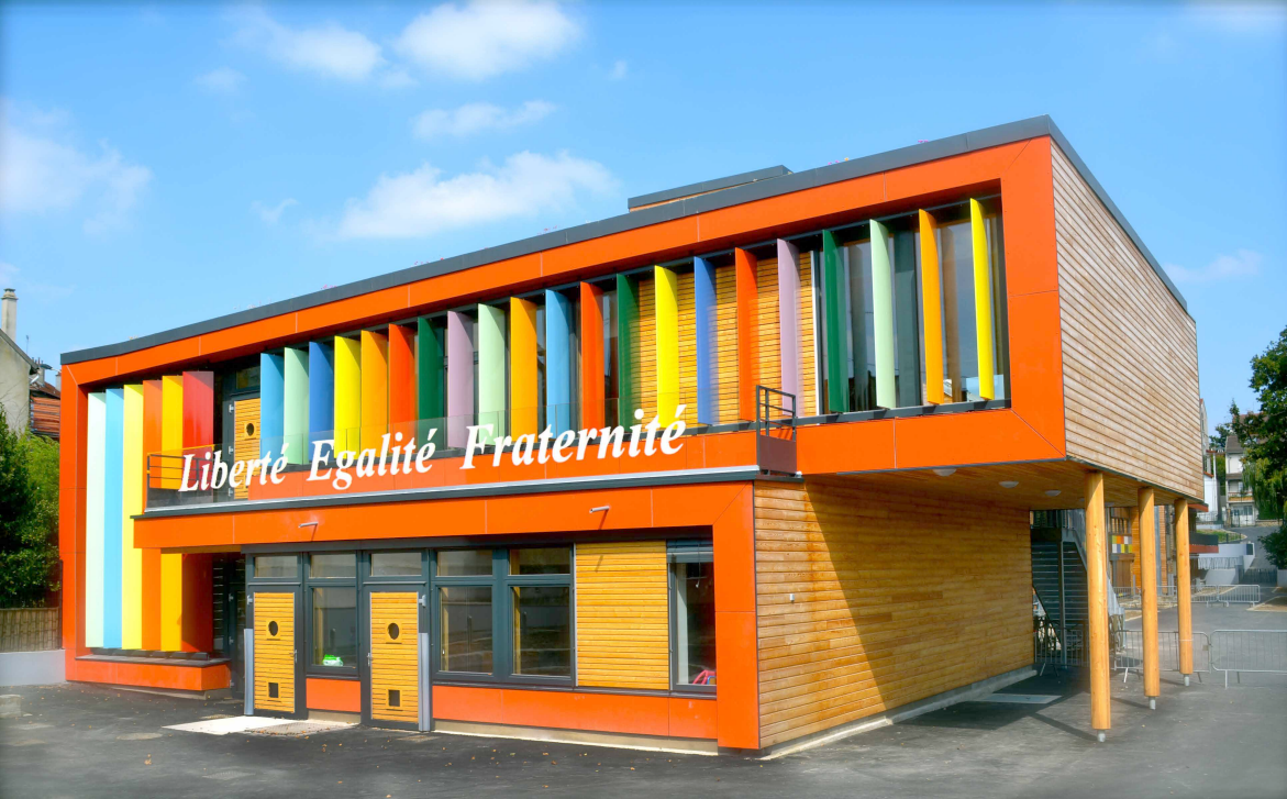
Façade de l'école Entrée principale
