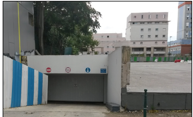
ENTREE D'UN PARKING (SOURCE : LES ENR)
