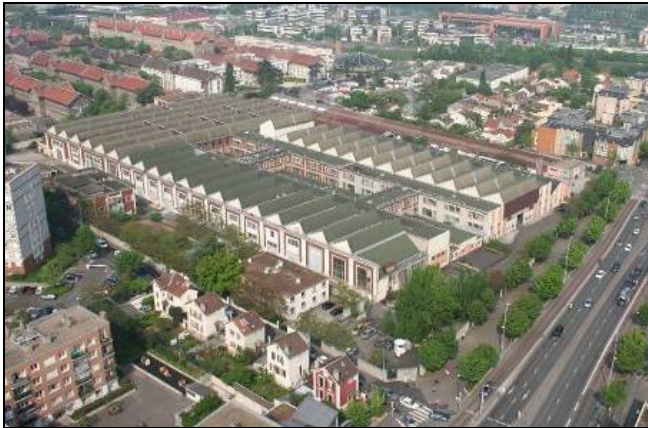
ÎLOT DE LA MARINE AVANT LA DEMOLITION DES BATIMENTS AYANT ACCUEILLI LA MARINE NATIONALE
