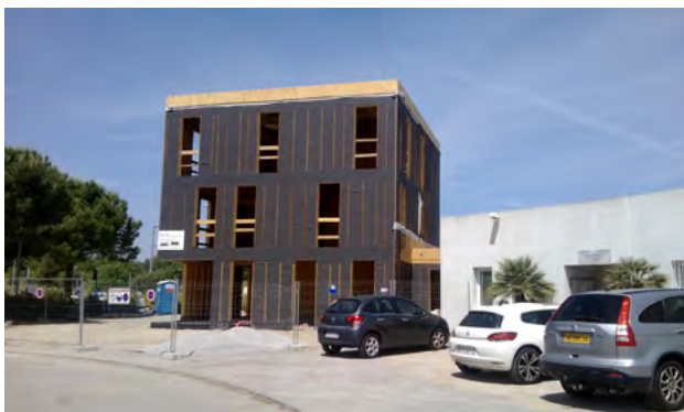
Photographies de chantier
