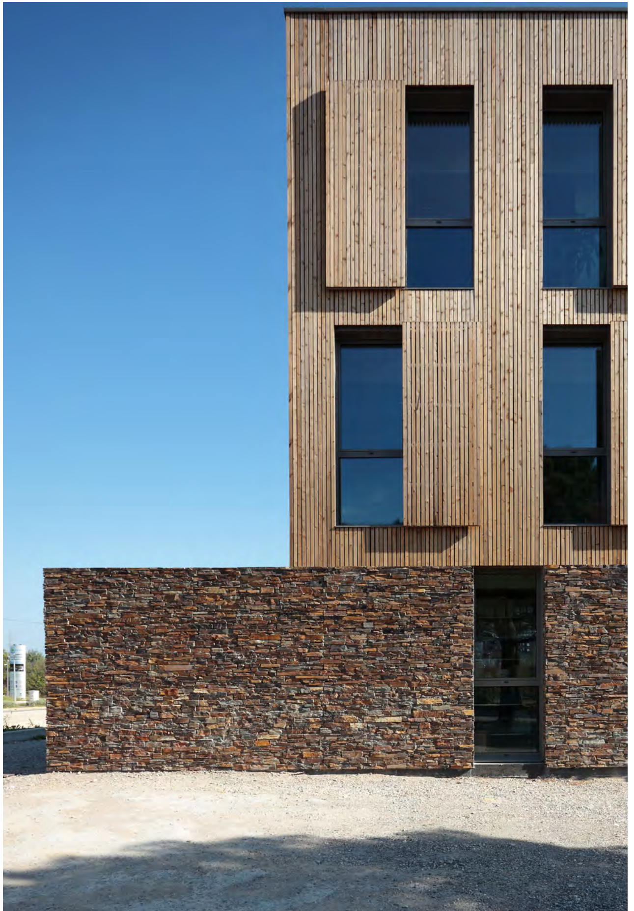
Détail façade Nord-Ouest
