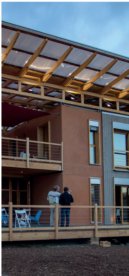
▼ Vue extérieur du prototype construit avec les étudiants. La bande centrale est enduite en terre. crédit : ENSAG / GA / ENSAL
