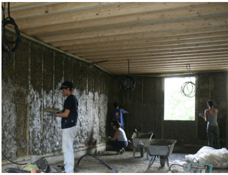
Chantier formation Apprentissage d'un savoir-faire cloison torchis, remplissage paille, enduit terre
