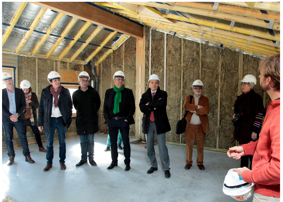
Transmission autour du projet Visite organisée avec le CAUE, Bordeaux Euratlantique, Cluster EcoHabitat, le CREHAD
