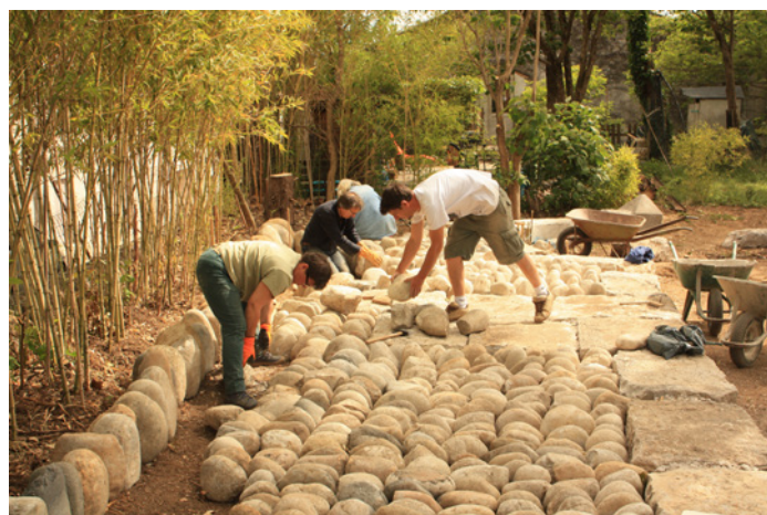
Atelier de réemploi des pierres (issues de la démolition de l'ancien mur d'enceinte) pour dessiner l'espace public
