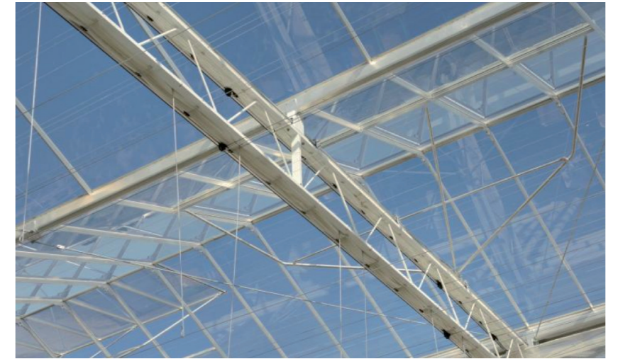
5 structure métallique + couverture vitrée
