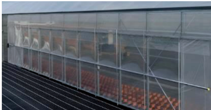
3 systèmes d'ouverture des ouvrants à enroulement vertical Toiles PVC ou ETFE
