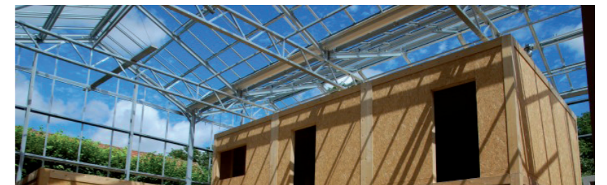
6 structure métallique + chéneau visitable (entretien des couvertures vitrées) 7 + passerelle technique (entretien des moteurs de crémaillères)
