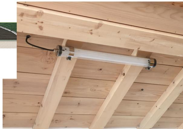
L'éclairage est à très basse consommation : réalisé en LED et dimensionné au plus juste, la puissance installée n'est que de 2 W/m<sup>2</sup> !
