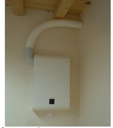
Le caisson, et le conduit permettant d'aspirer l'air neuf et rejeter l'air extrait **à travers le mur**.
