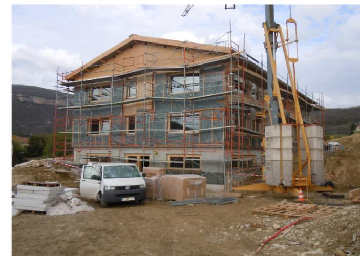
... les murs préfabriqués sont apportés par camion et assemblés à la grue par panneaux de 4 à 5 m de long et de hauteur d'étage.
