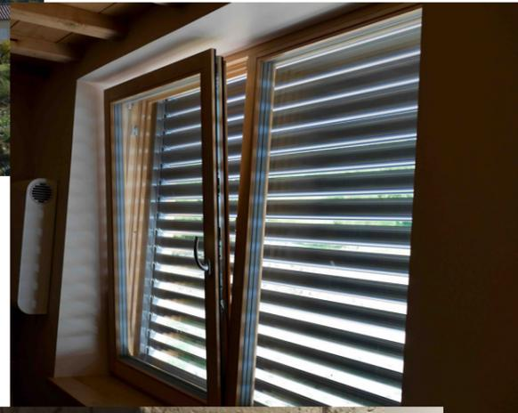
**Aération nocturne** : nous laissons entrer la fraicheur la nuit avec les fenêtres oscillo-battantes. Les BSO assurent la protection contre la pluie et l'intrusion.
