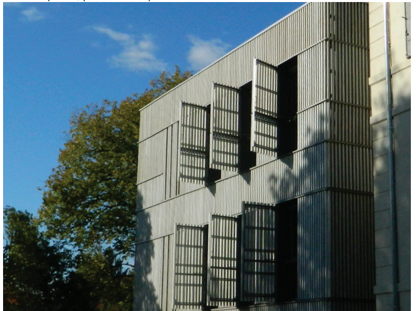
Le pin d'Alep en Façade Sud de l'Extension
