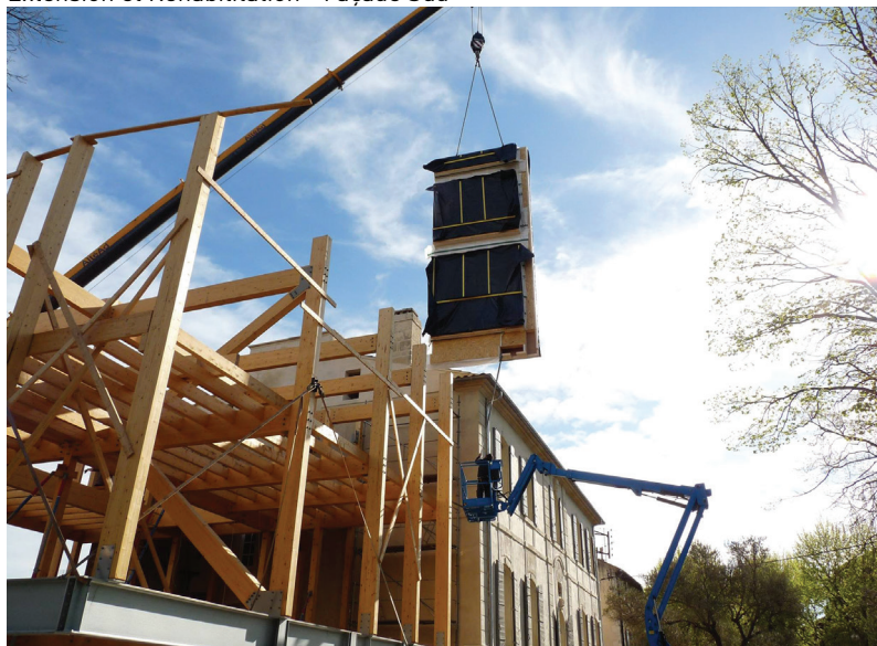
Extension - Gruetage des panneaux isolés (caissons de paille)
