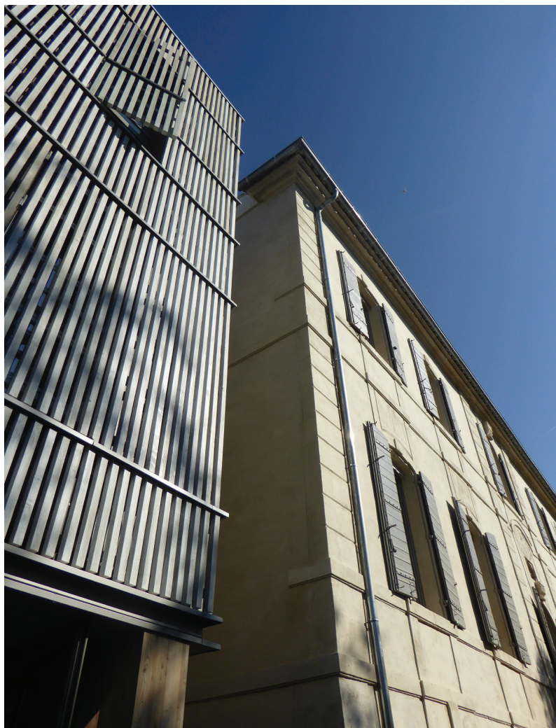
Extension et Réhabilitation - Façade Sud
