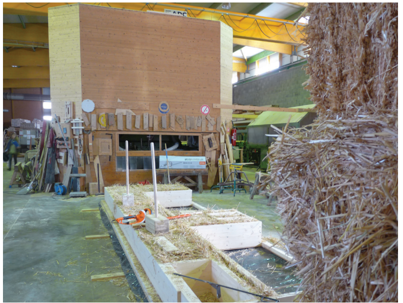
La paille comprimée à l'intérieur des caissons
