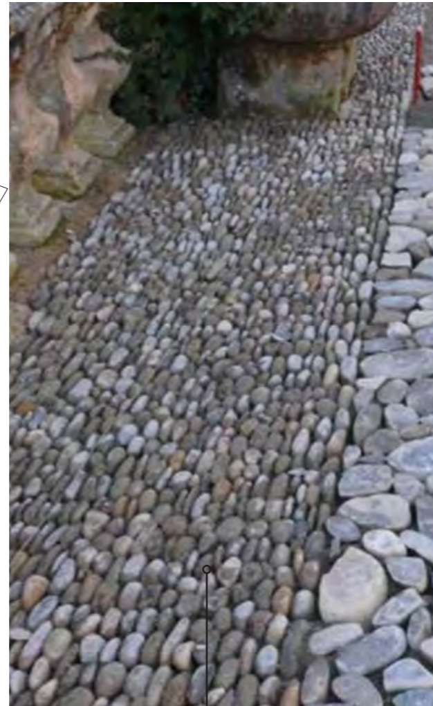
> à l'interface de la bande tous modes et la noue paysagée sud > galets petits calibre posés en rangs parallèles et sur tranche
