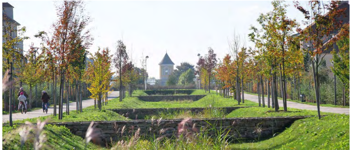
large noue d'infiltration entre deux voiries avec compartiments de rétention
