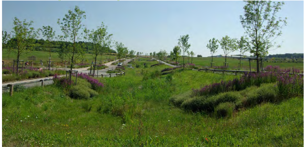
large noue d'infiltration entre deux voiries avec plantations champêtres
