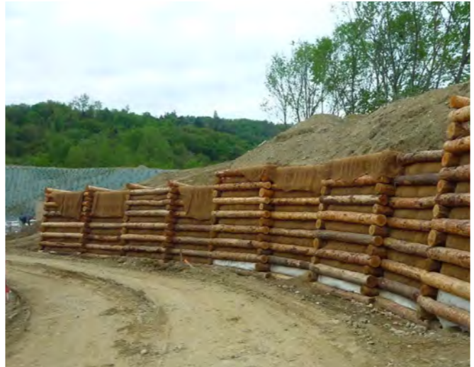
caissons bois pour soutènement de berges et de compartiments de rétention
