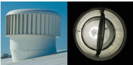
Exemple de tourelle de ventilation naturelle Hurricane Ventilator de Edmonds et son registre intérieur de régulation
