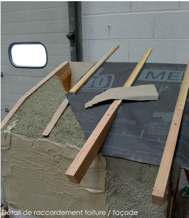
Mise en oeuvre du béton de chanvre
