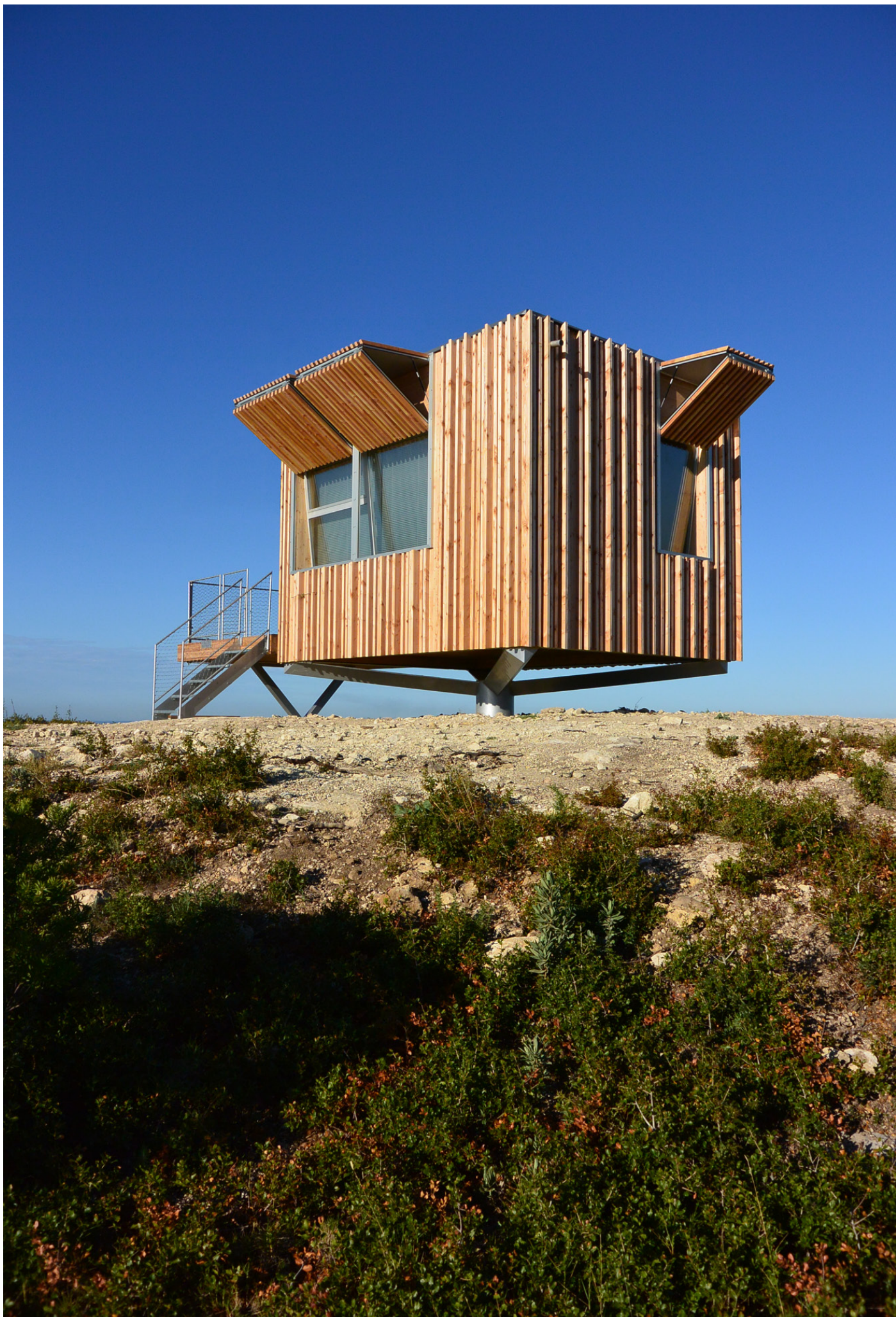
Vigie de détection des feux de forêt - 13
