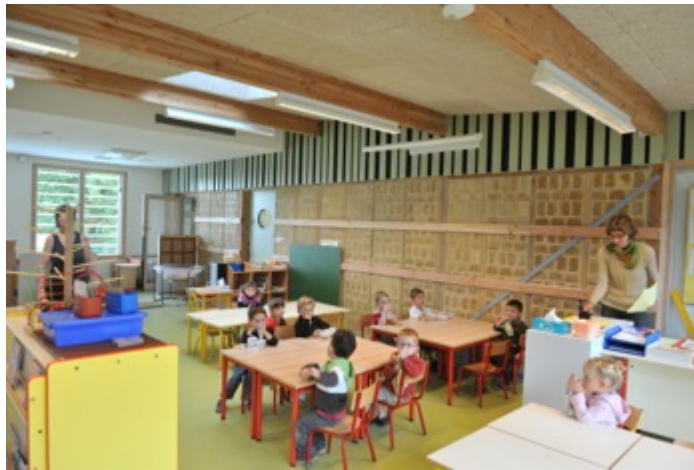
photo 7 : salle de cours ossature bois + BTC
