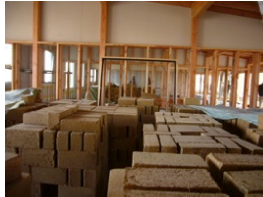
photo 4 : stockage des blocs de terre
