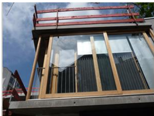
Vue sur un "mur trombe" en phase chantier
