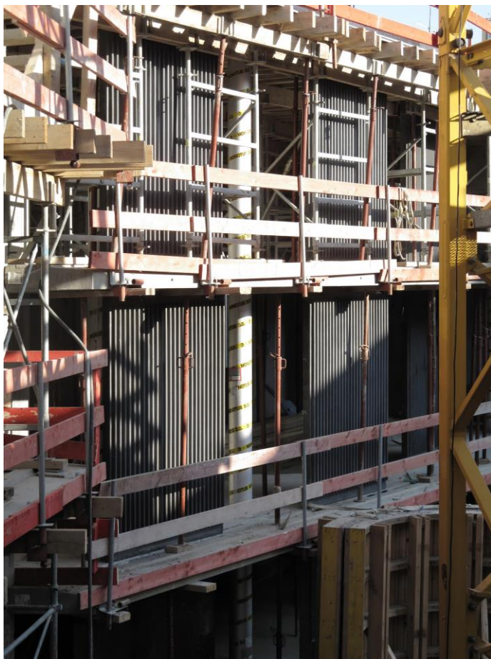
Mise en oeuvre des éléments en béton préfabriqué | © BNR
