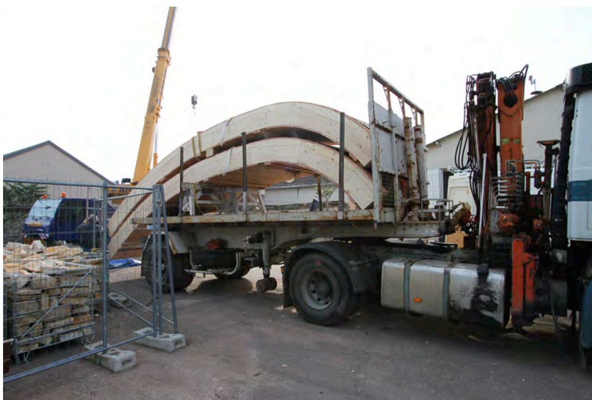
Arrivée des caissons bois en planches reconstituées par clouage (sans colle) et remplissage en bottes de paille cultivées en Biodynamie
