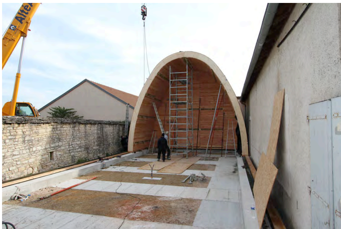
Montage des caissons sur le chantier - temps de pose 1 semaine
