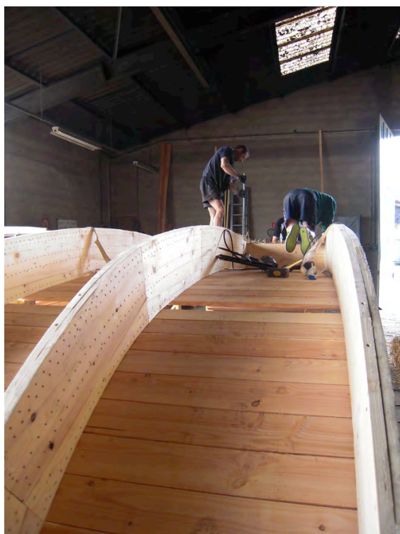
Montage des caissons et arcs en BRC: bois reconstitué par clouage (pas d'utilisation de colle dans le bâtiment)
