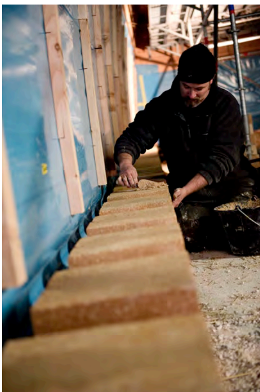
Mise en oeuvre de briques de terre crues en pied de voûte sur 1m80 de haut afin de réguler l'hygrométrie du lieu
