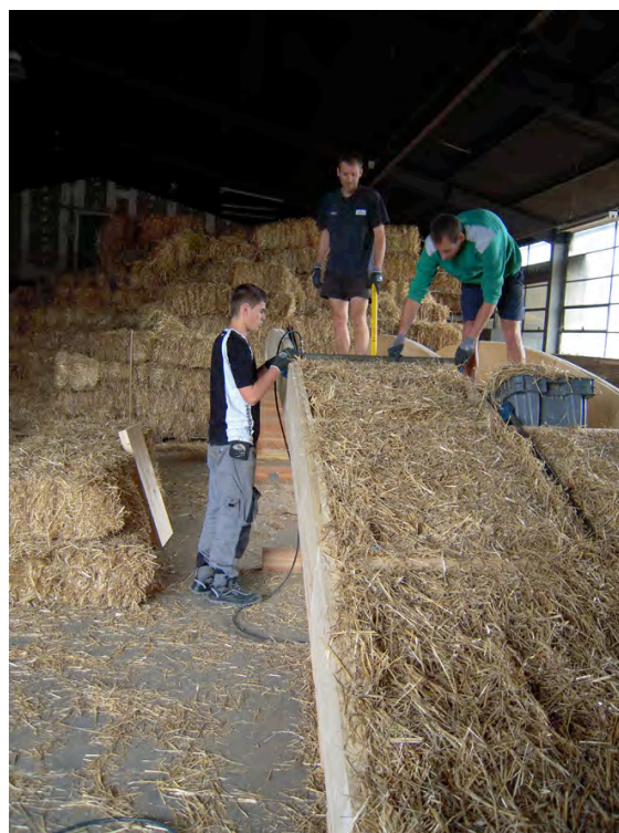
Remplissage des caissons avant la pose de la volige de chaque côté
