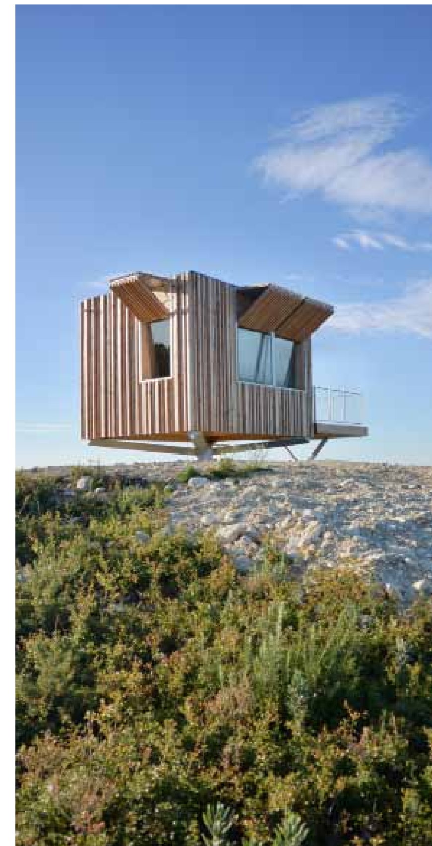
Vigie de détection des feux de forêt dans le massif de Figuerolles (13), OH!SOM architectes
