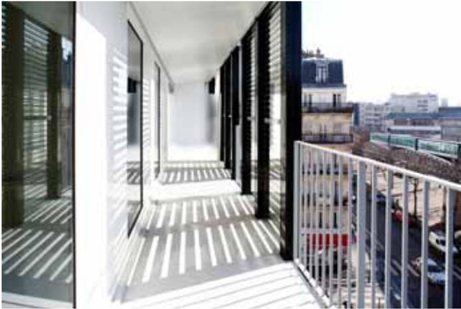
les capteurs solaires forment une double peau qui abrite des loggias protégées des nuisances
