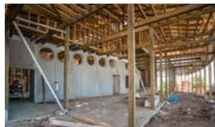
vue du hall avec les percements du voile béton matricé pour intégrer les gaines d'amener d'air en sous-face des gradins.
