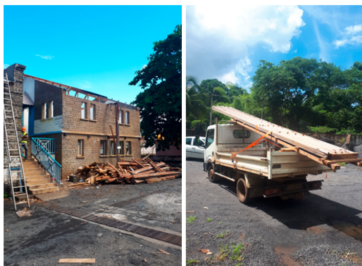
Démolition, transport et stockage des matériaux de réemploi
