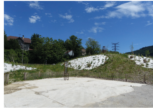
Réemploi - Buttes paysagères (déblai/remblai)
