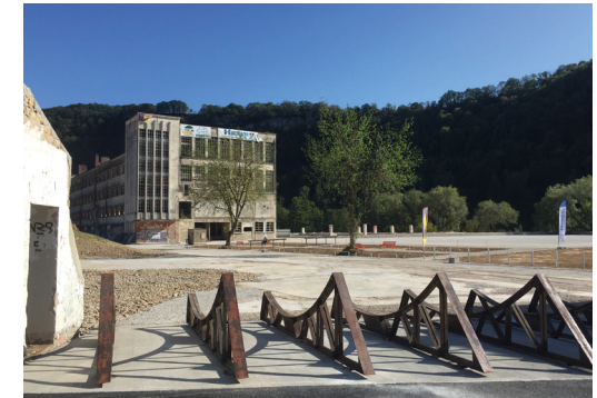
Réemploi - Les fermes de la charpente - Entrée
