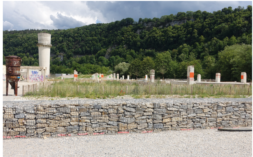
Réemploi - Mur (pierres du mur d'enceinte démolie)
