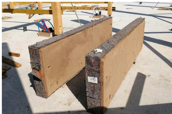
La double approche low-tech et high-tech s'exprime dans l'architecture de Résilience : les façades composées de fenêtres de réemploi en simple vitrage, et de caissons remplis de paille compressée recouvertes d'enduit en terre crue aux deux faces (fabriqué en Ukraine par Rainbow Ecosystem) côtoient une thermo-frigo-pompe fièrement installée dans un container à l'extérieur du bâtiment ! Cette technologie de pointe produit en même temps du froid et du chaud avec peu d'énergie.
