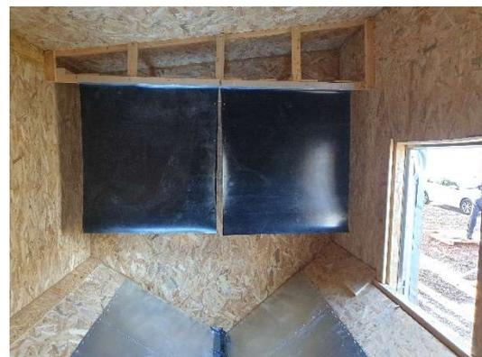
Le silo est équipé de deux pans coupés montés sur palettes et pieds de support, pour amener les pellets vers la vis sans fin au centre du bâtiment.
