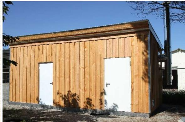
Côté chaudière, associé à une porte coupe-feu ½ heure, un complexe de deux couches croisées de fermacell® de 15mm d'épaisseur, puis une couche de 70mm de laine de roche recouverte elle aussi par à nouveau deux couches de fermacell® de 15mm, pour tenir un coupe-feu de 2 heures. Au sol, des dalles Aestuver® de 25mm.
