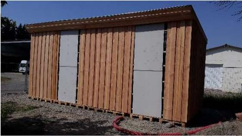
Pas de besoin d'isolation thermique par l'extérieure pour ce bâtiment, uniquement un pare-pluie, des tasseaux, le tout recouvert d'un bardage en Douglas avec une pose verticale par recouvrement.
