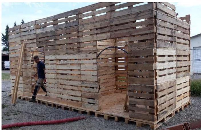
Ensuite il s'agit de maçonner les palettes à l'aide du dispositif breveté Sylcat ([www.sylcat.eu](http://www.sylcat.eu)) pour réaliser l'ossature.
