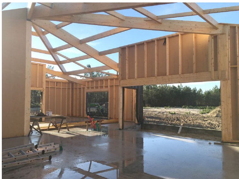
Photographie du chantier où l'on peut voir l'ossature bois et la charpente
