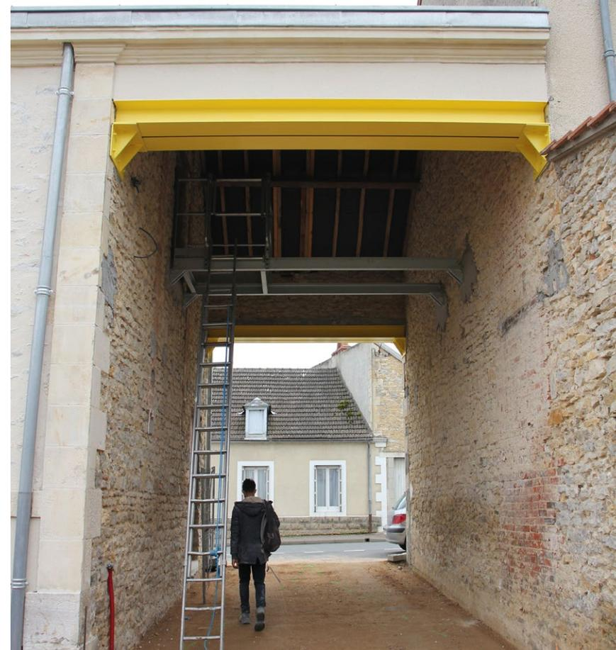
*L'accès des véhicules à la parcelle est réalisé par la suppression d'une trame ajoutée a posteriori*
