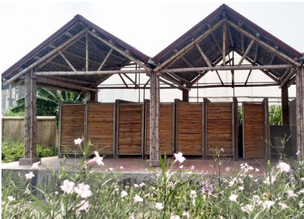
Photo de chantier, après la pose des portes en bambou
