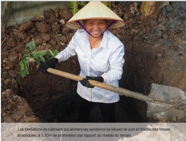
Les fondations du bâtiment qui abritera les sanitaires se situent de part et d'autre des fosses septiques, à 1,30m de profondeur par rapport au niveau du terrain.
