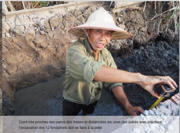
Etant très proches des parois des fosses et distancées les unes des autres avec précision, l'excavation des 12 fondations doit se faire à la pelle.
