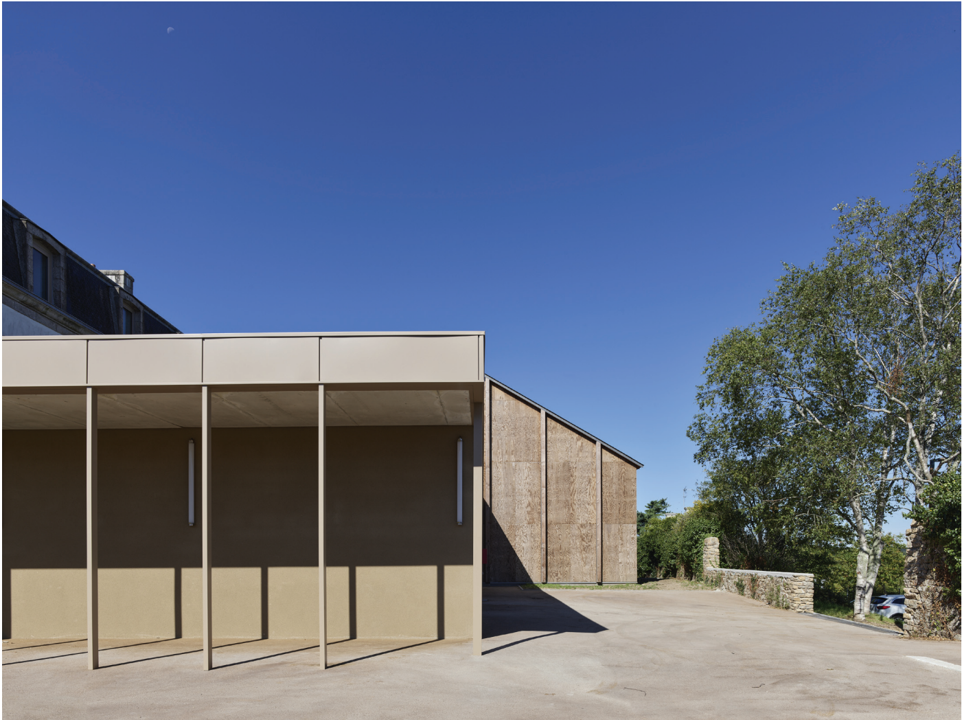
parvis d'entrée et cour technique
