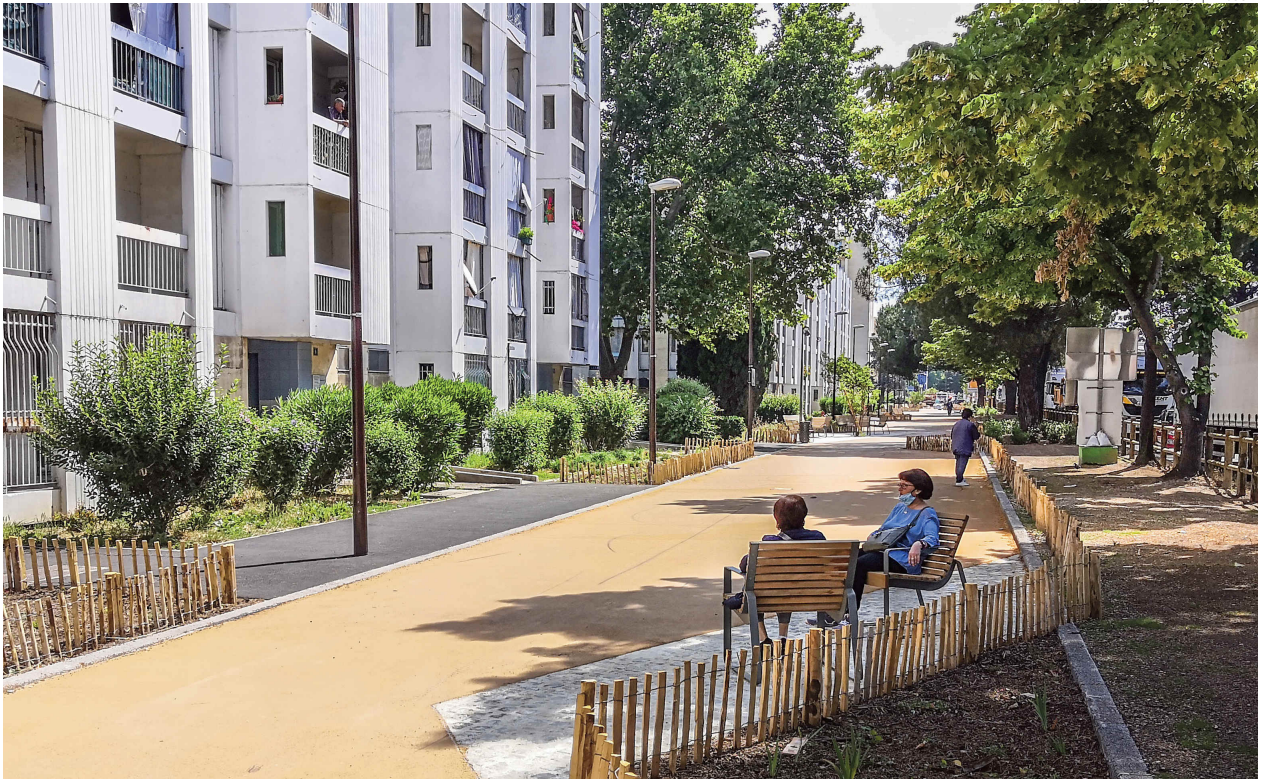
Photo visite de chantier | juin 2020
