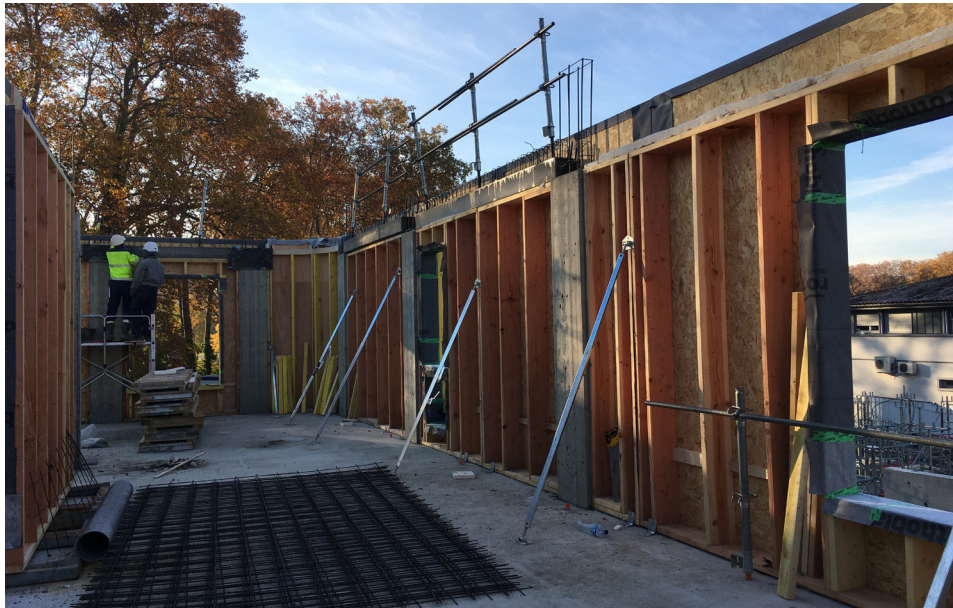
Plus de créativité, moins de consommation: ici le bois sert de coffrage au béton
