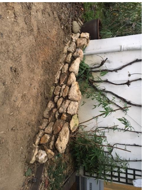
Muret en pierres issues du mur de la maison (joints en terre semée)
