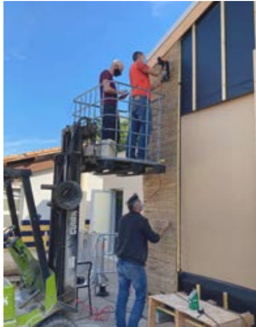
pose des rouleaux de roseaux par le maire et les élus et les architecte
