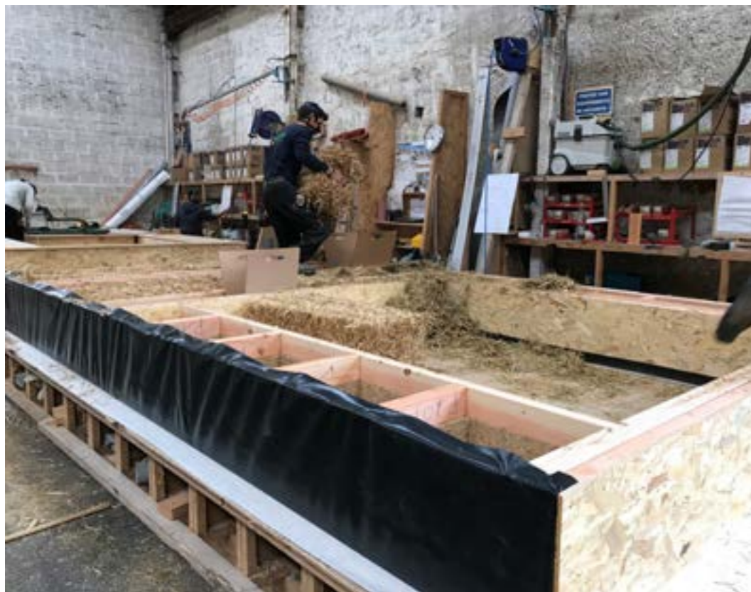
remplissage en paille des ossatures bois en atelier (Batinature)
