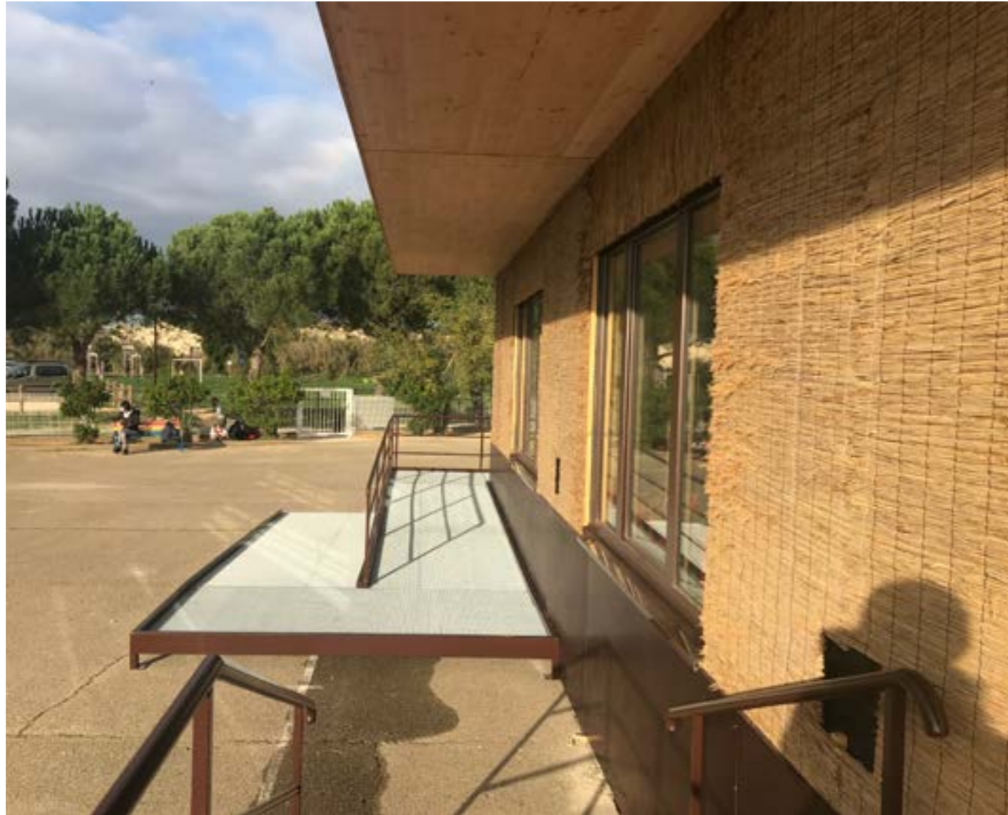
photo de la façade Sud
