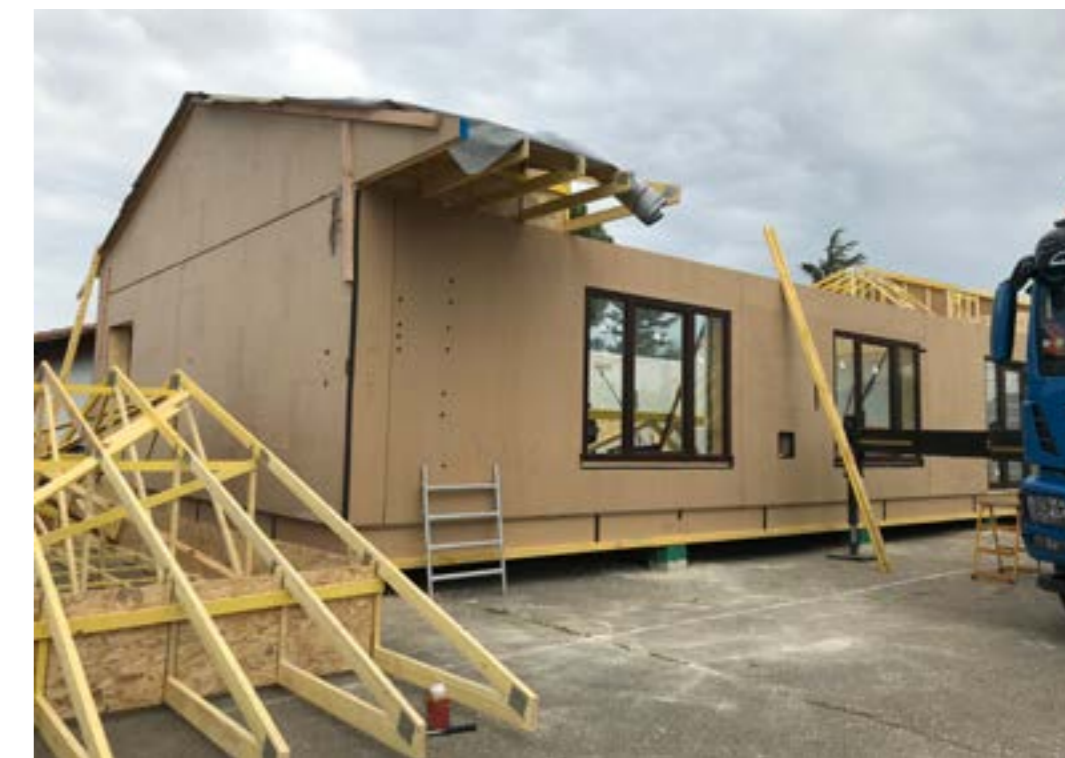
montage de la charpente
