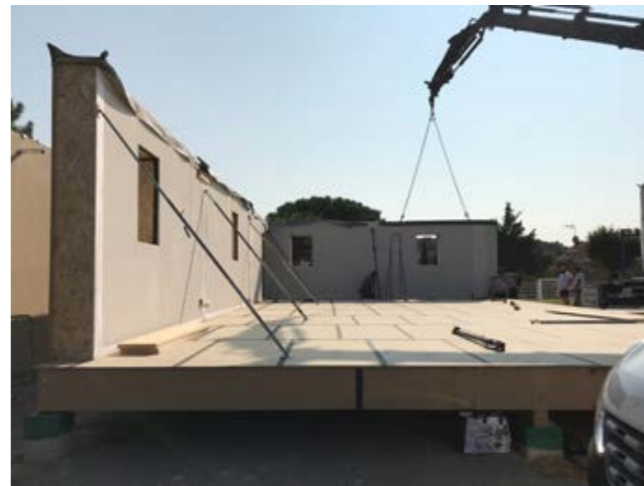
assemblage des modules
