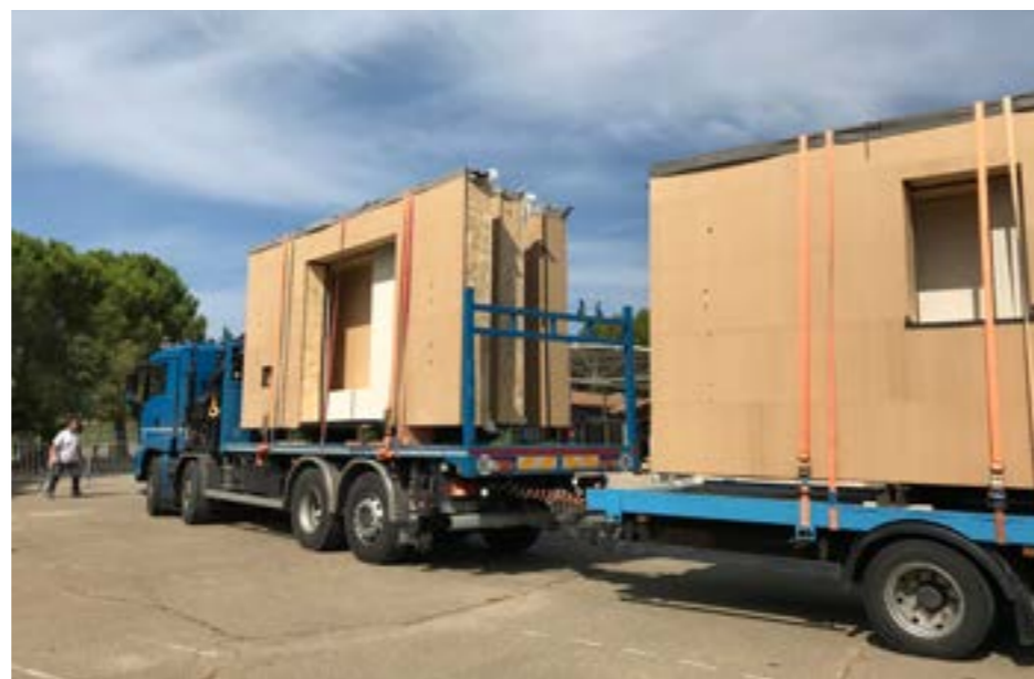
arrivages des modules sur chantier
