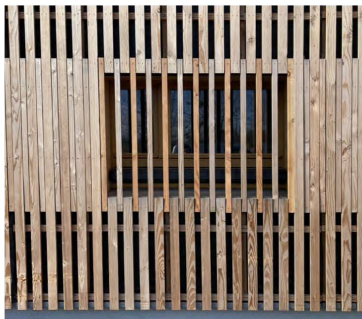
menuiseries extérieures en chêne, grilles d'entrées d'air en partie basse
