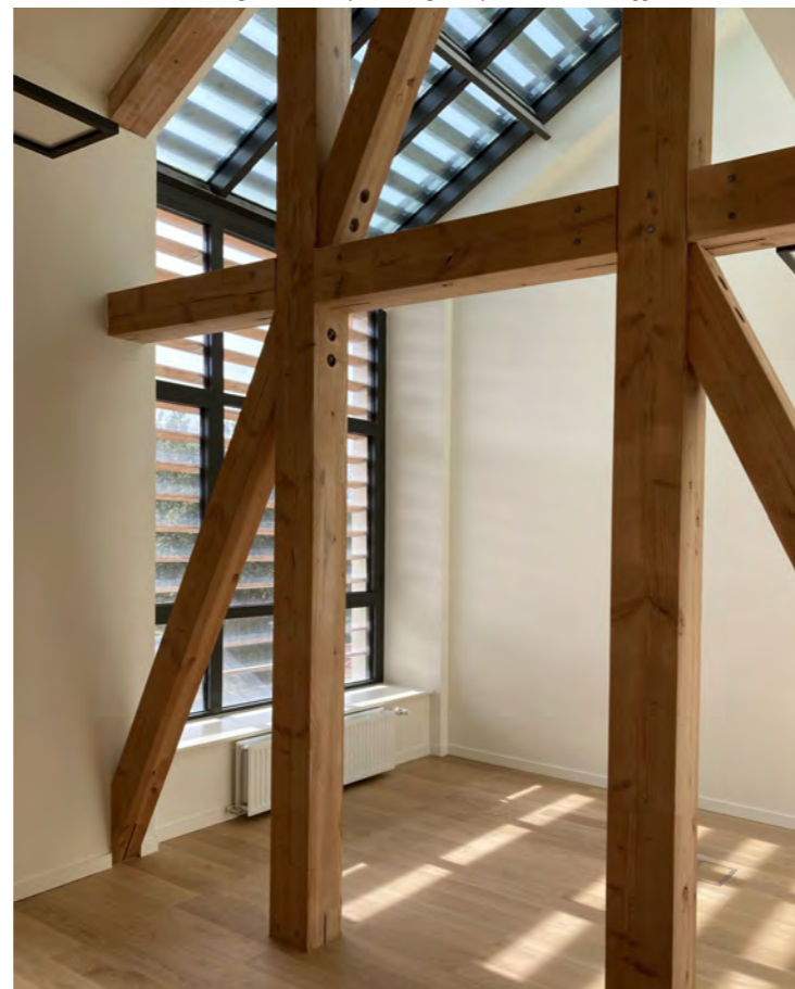
le percement en double hauteur dans les bureaux
