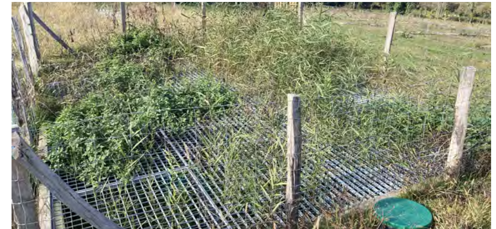
mise en place du bassin de phytoépuration
