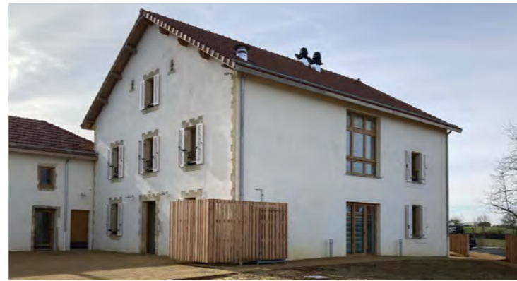
les façades ont été piquées et enduites à la chaux
