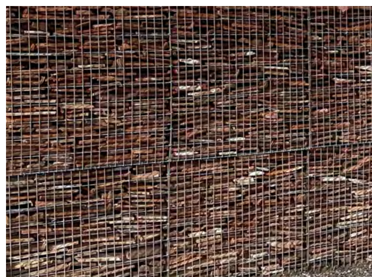
réutilisation des tuiles déconstruites en gabions
