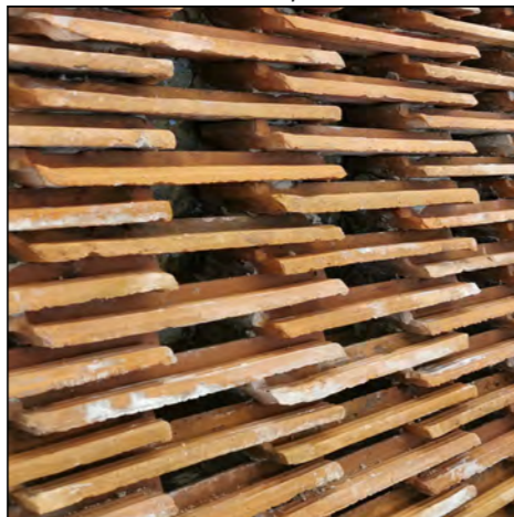
reemployées en cloisons de tuiles
