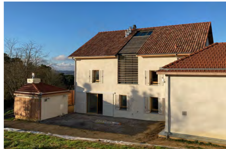
la terrasse du logement protégée par la chaufferie
