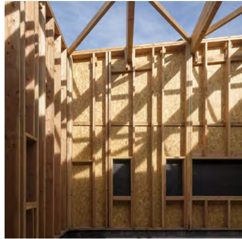
murs à ossature bois
