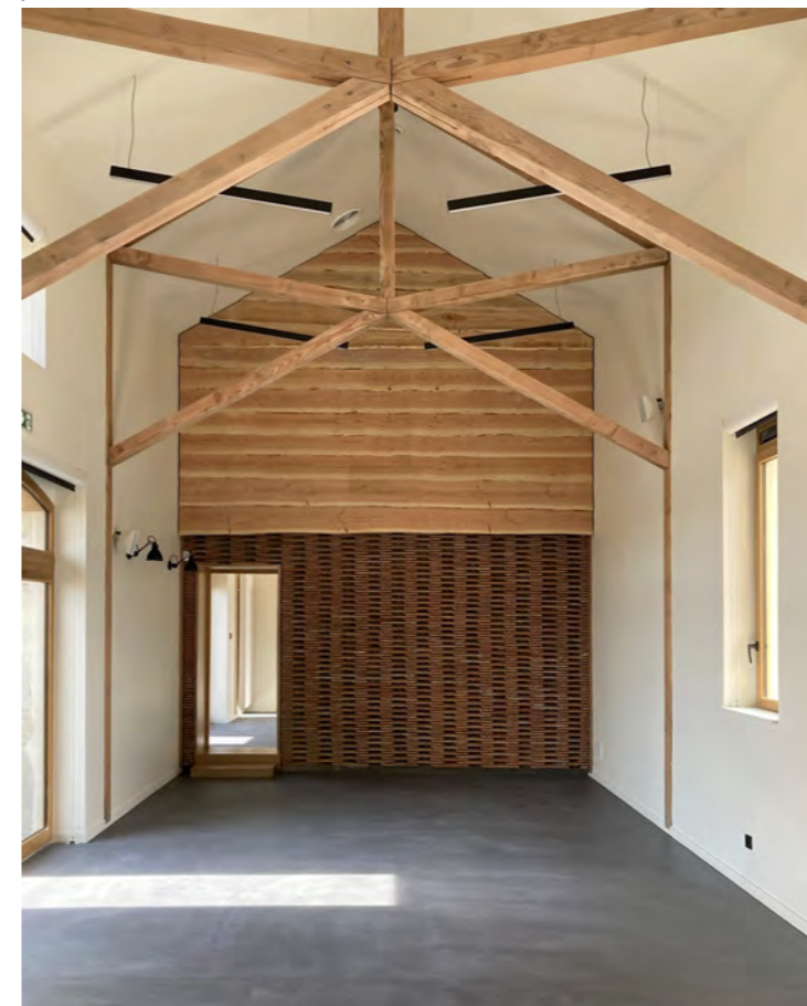
dans la salle de séminaire, la cloison en tuile réutilisées est surmontée d'un bardage non raboté en douglas brut
