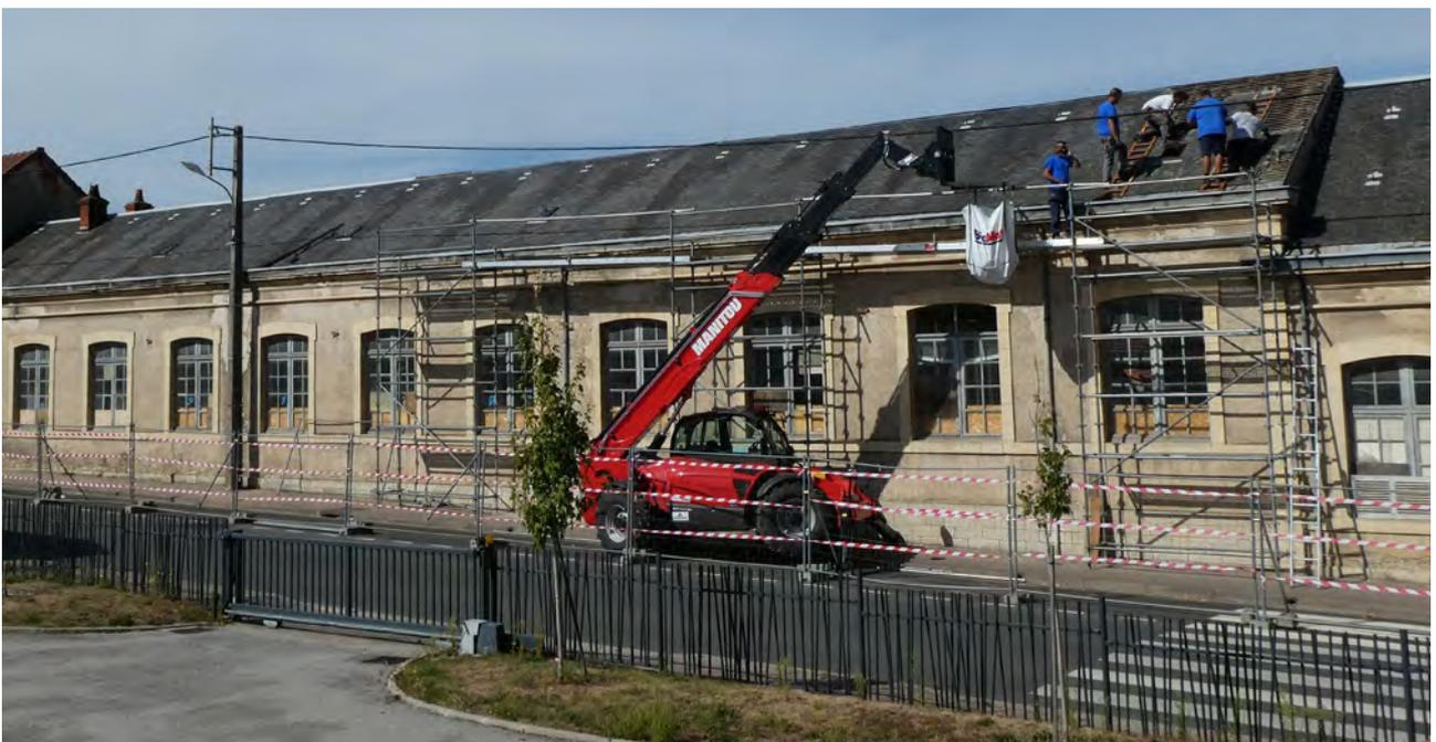
↑ Dépose soignée d'ardoises pour réemploi ultérieur ( paillage sous les coursives)
