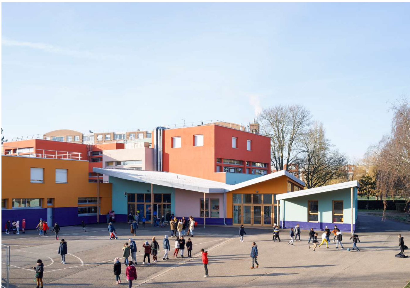
Groupe scolaire Jean Macé après travaux : vue sur l'extension centre de loisirs et hall d'entrée
