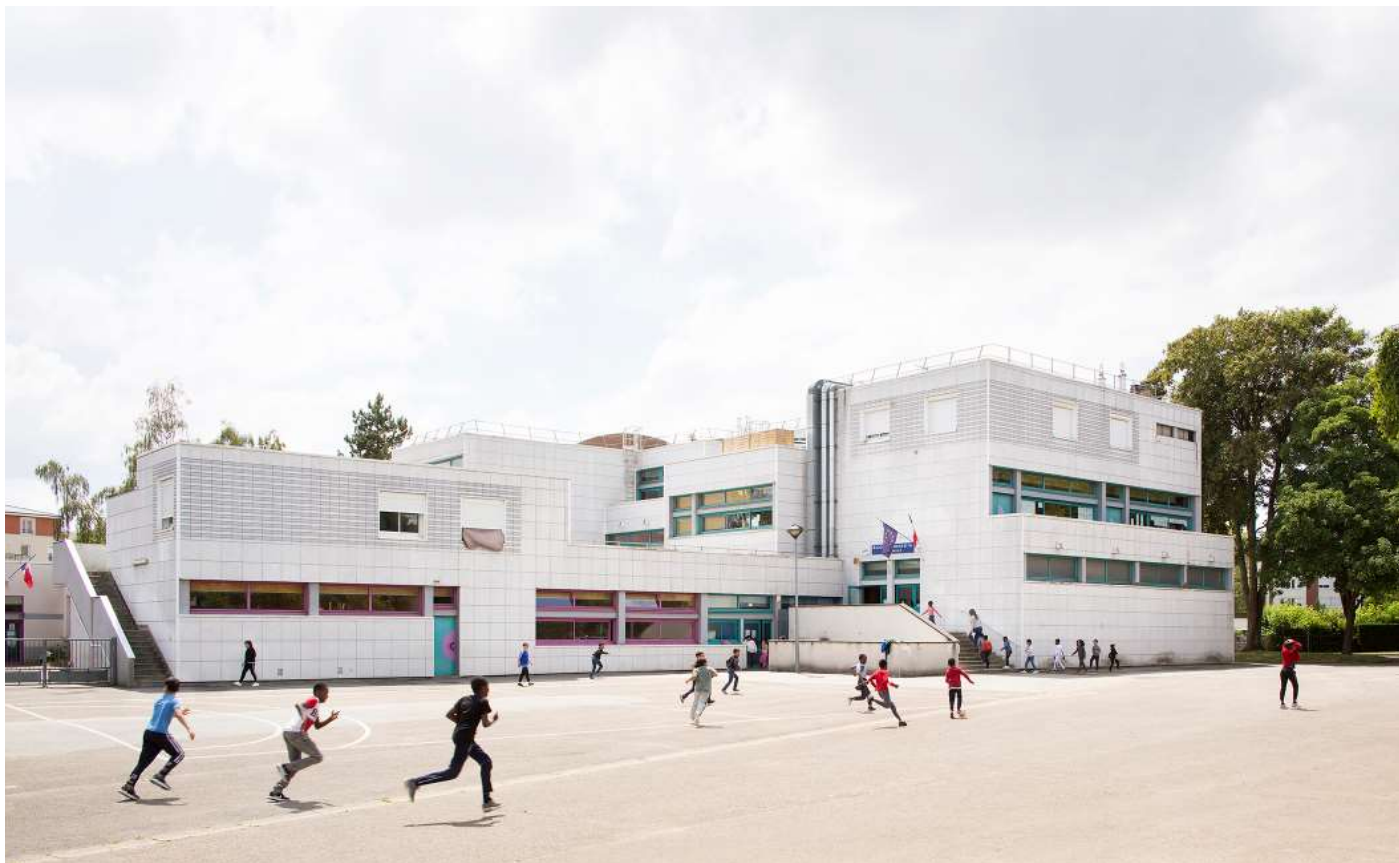
Groupe scolaire Jean Macé avant travaux : vue sur l'entrée principale de l'école élémentaire et la cantine
