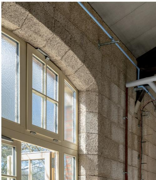
Détail du traitement stéréotomique des blocs de chanvres formant l'arc de la baie.
