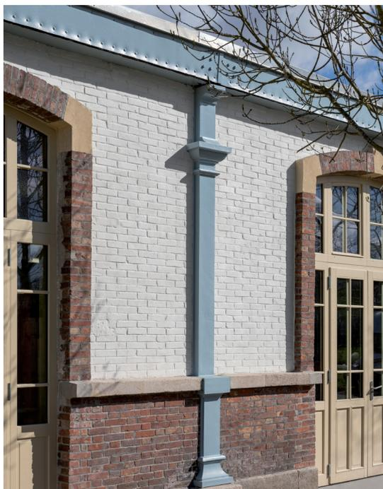
Détail des modénatures de la façades – pilastres en fonte, cadre des baies, bandeaux soubassements et remplissages en briques et pierre – restitués dans leur matérialité brute ou couleur d'origine.
