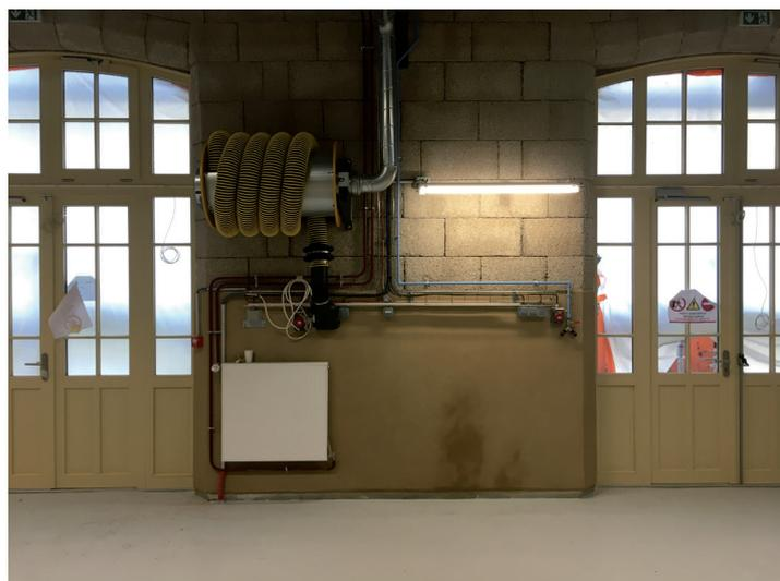
Un poste de travail. L'enduit terre est implanté jusqu'à 1.50 m, délimitant l'espace de travail et l'implantation des passages de réseaux horizontaux. Verticalement, ces derniers cheminent dans l'axe des pilastres.
