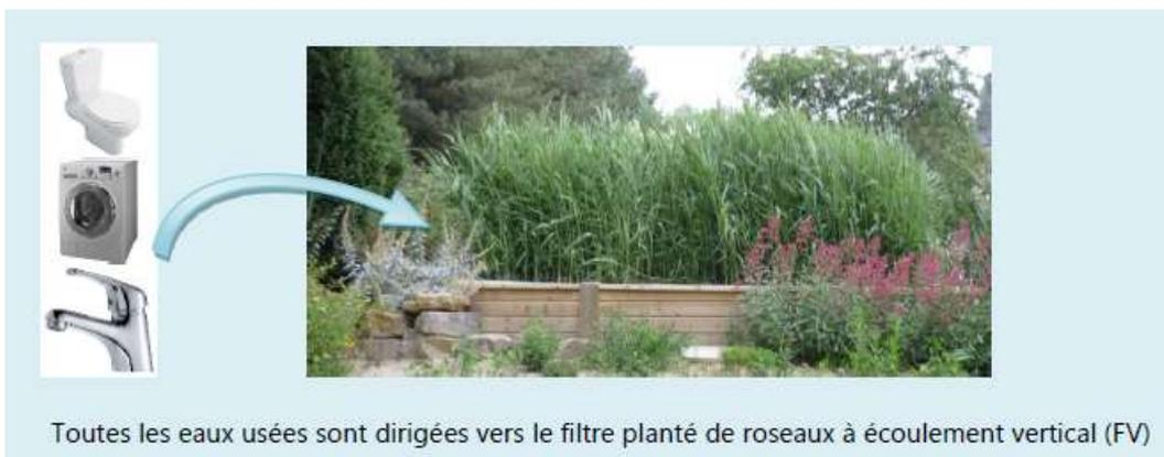
Toutes les eaux usées sont dirigées vers le filtre planté de roseaux à écoulement vertical (FV)
