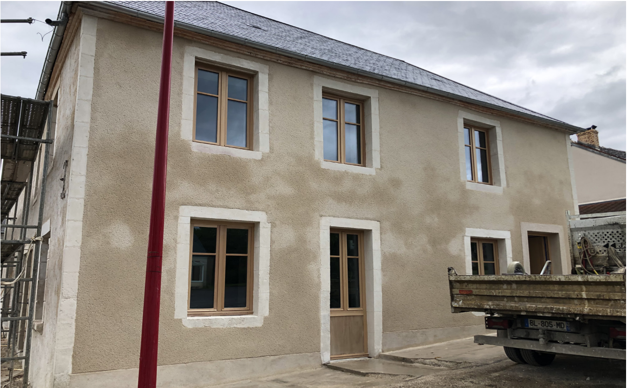
Protéger avec des matériaux bio-sourcés (enduit à la chaux perspirante- chaux sable local)
