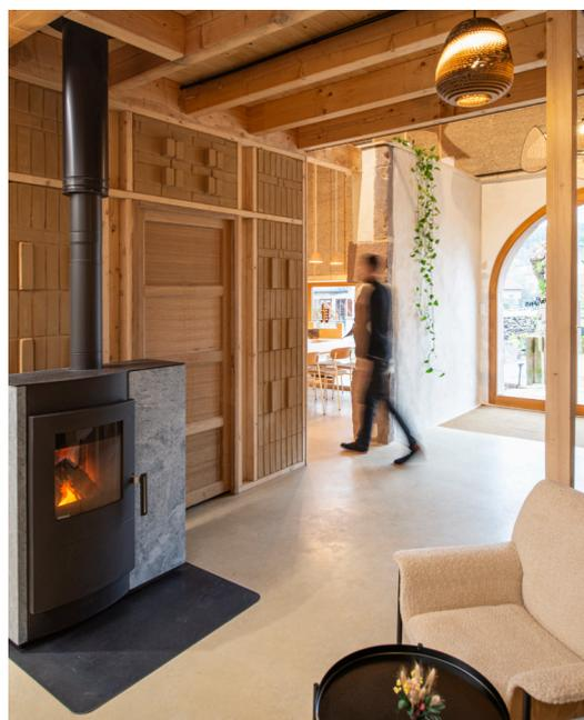
Ces briques proviennent de la briqueterie Lanter qui travaille le loess alsacien depuis les années 30 en fabriquant des briques, des tuiles ou des tomettes. Elles ont été maçonnées à l'aide d'une barbotine dans les niches d'une cloison en ossature bois.
