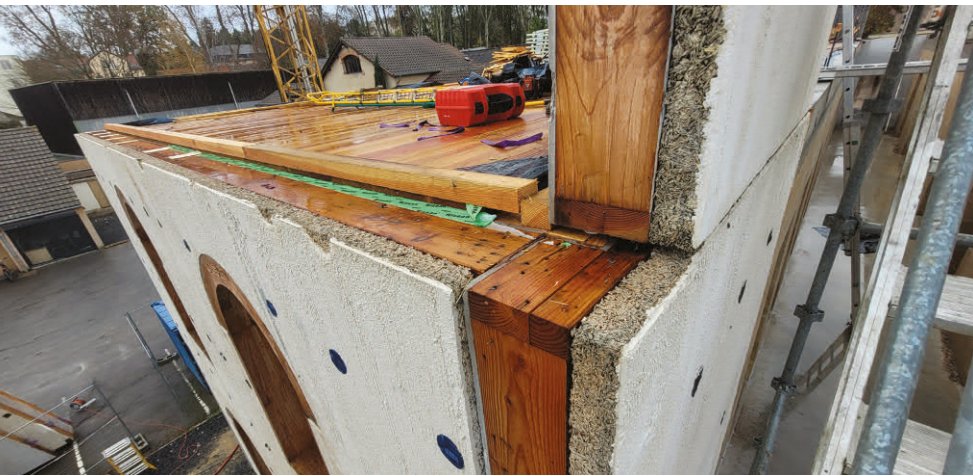
Assemblage des murs périphériques Wall'up (bois/béton de chanvre) ■ 2023 ■ ©Julie herrgott
