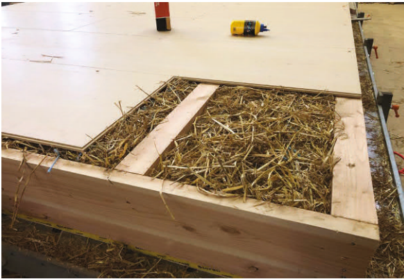
Caissons de toit : structure bois, isolation paille ■ 2024 ■ ©Charpentiers du Haut Beaujolais
