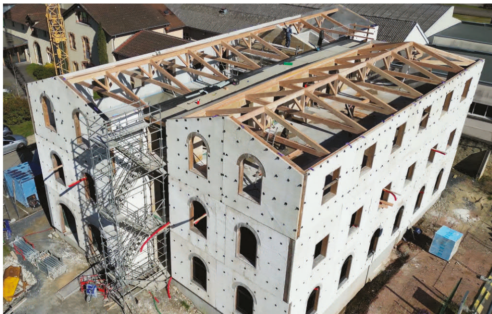
Murs Wall'up et charpente traditionnelle en douglas massif ■ 2024 ■ ©Charpentiers du Haut Beaujolais
