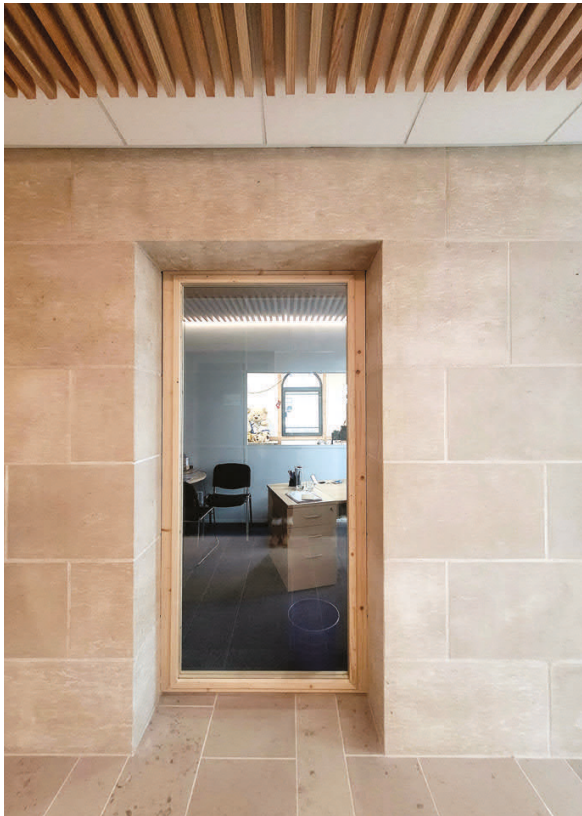
RDC, couloir central : mur de refend en pierre de Lanvignes, châssis fixe en pin local, vitrage de réemploi, sol en Comblanchien, plafond en Sylvacoustik 2024 ■ ©Julie Herrgott
