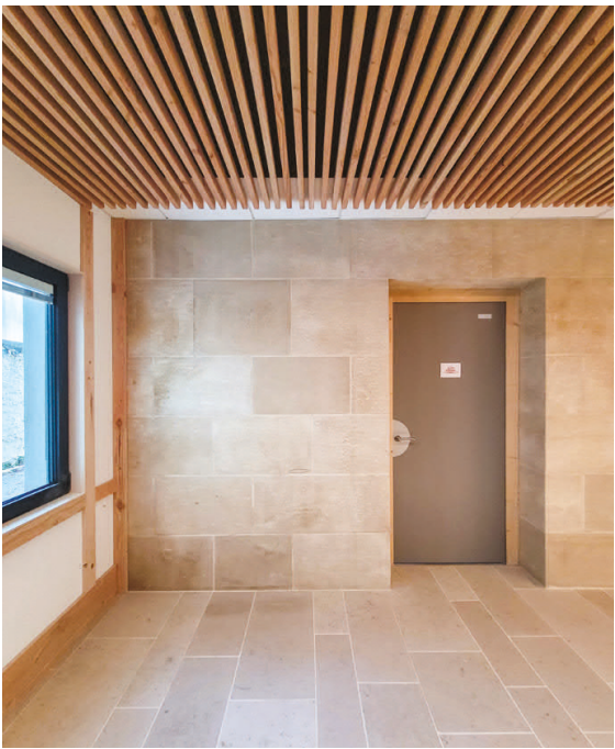
RDC, couloir central : mur de gauche : façade Est, mur Wall'up, mur de refend en pierre de Lanvignes, sol en pierres de Comblanchien, plafond en Sylvacoustik ■ 2024 ■ ©Julie Herrgott
