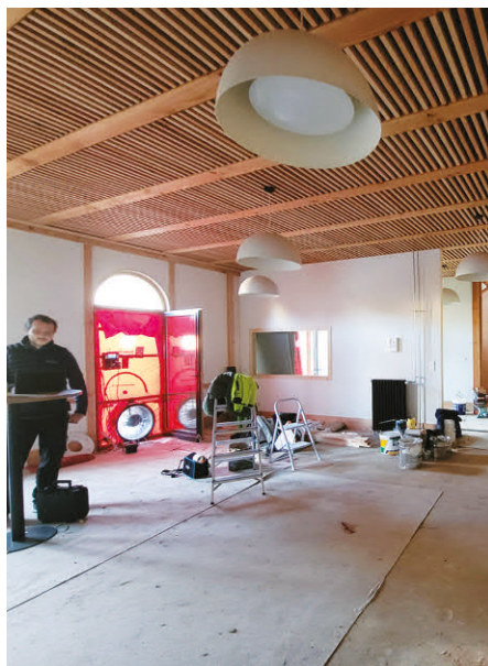
Test d'étanchéité à l'air réalisé par Aerology, en présence de Vincent Pierré de Terranergie ■ 2024 ■ @Julie Herrgott
