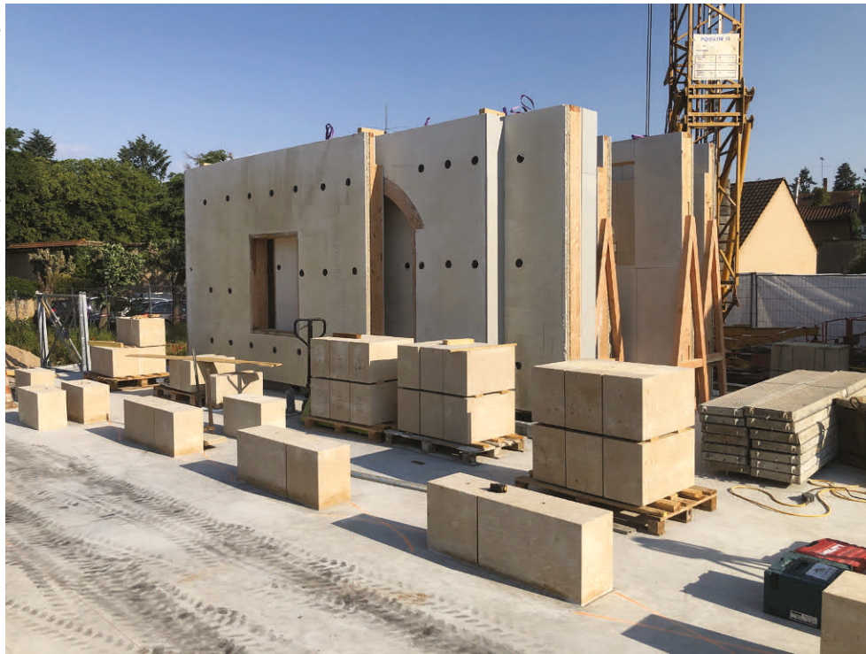
Murs périphériques Wall'up livrés sur chantier et démarrage des murs de refend en blocs de pierre de Lanvignes ■ 2023 ■ ©Julie Herrgott
