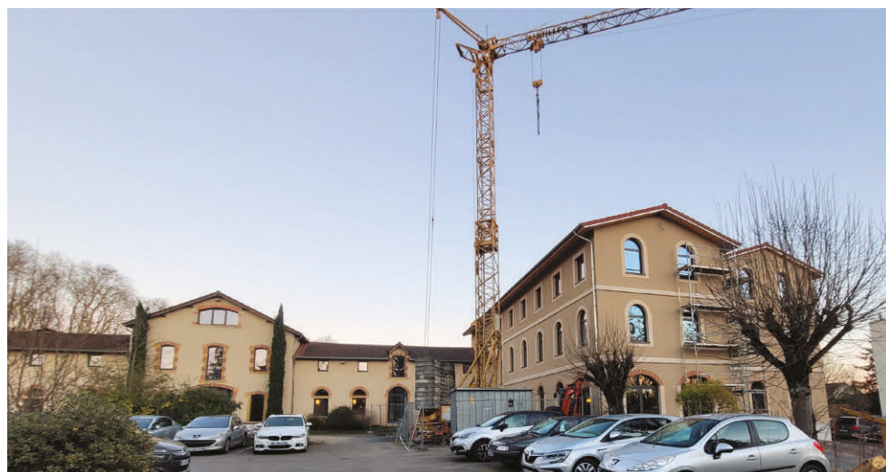
Façade Ouest du bâtiment Haras auquel s'adosse la nouvelle extension baptisée l'Arboretum ■ 2024 ■ @Julie Herrgott
