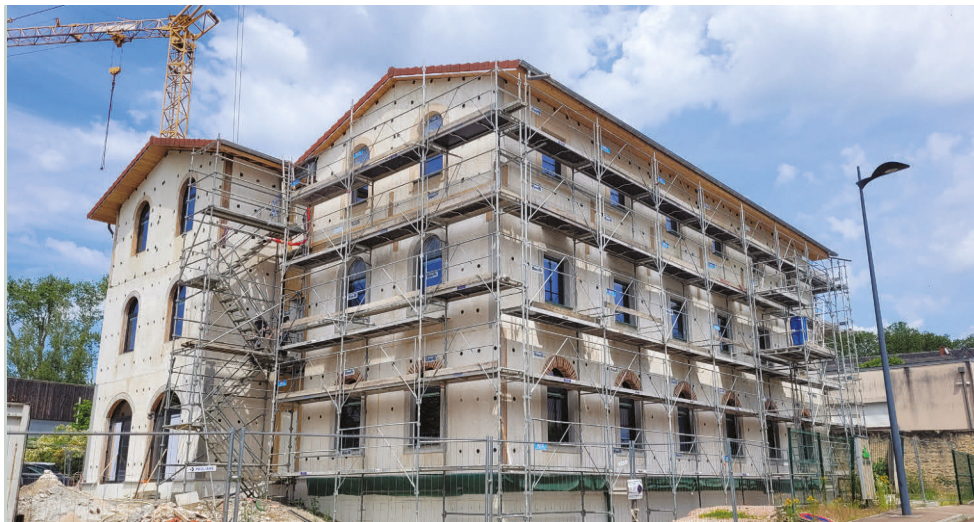
Façades Sud et Ouest échafaudées ■ 2024 ■ ©Julie Herrgott
