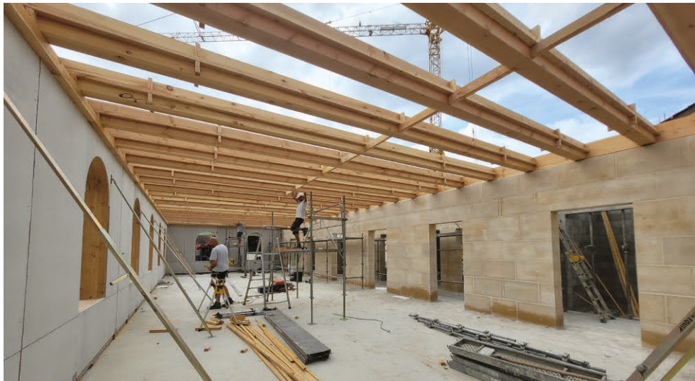
R+1 en chantier, MOB Wall'up, refends en blocs de pierre, solives en bois massif ■ 2023 ■ ©Julie Herrgott
