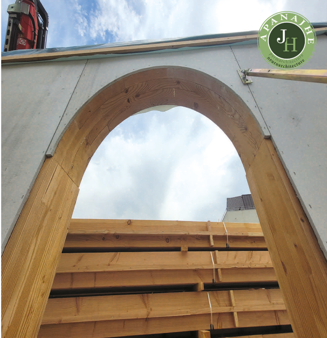
Linteau cintré en bois d'une menuiserie extérieure ■ 2023 ■ ©Julie Herrgott
