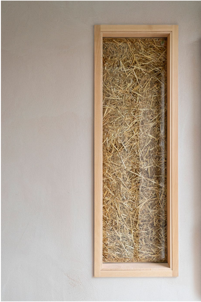
Les cloisons en hêtre local (parement, structure et isolation mêtisse). La fenêtre de vérité dans l'extension donne à voir l'isolation en bottes de paille.
