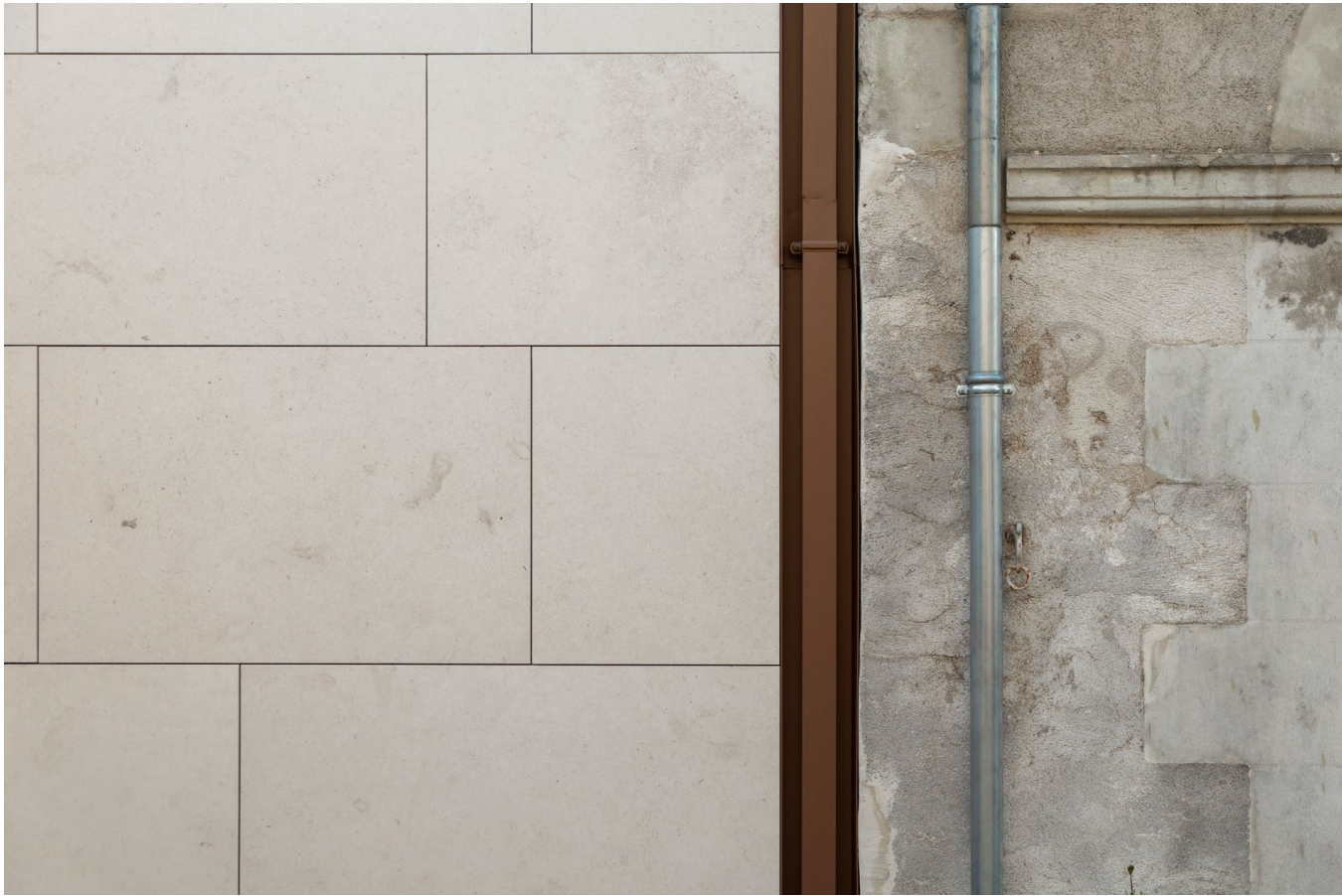
La descente d'eaux pluviales de l'extension traitée comme un joint creux avec le bâtiment existant.
