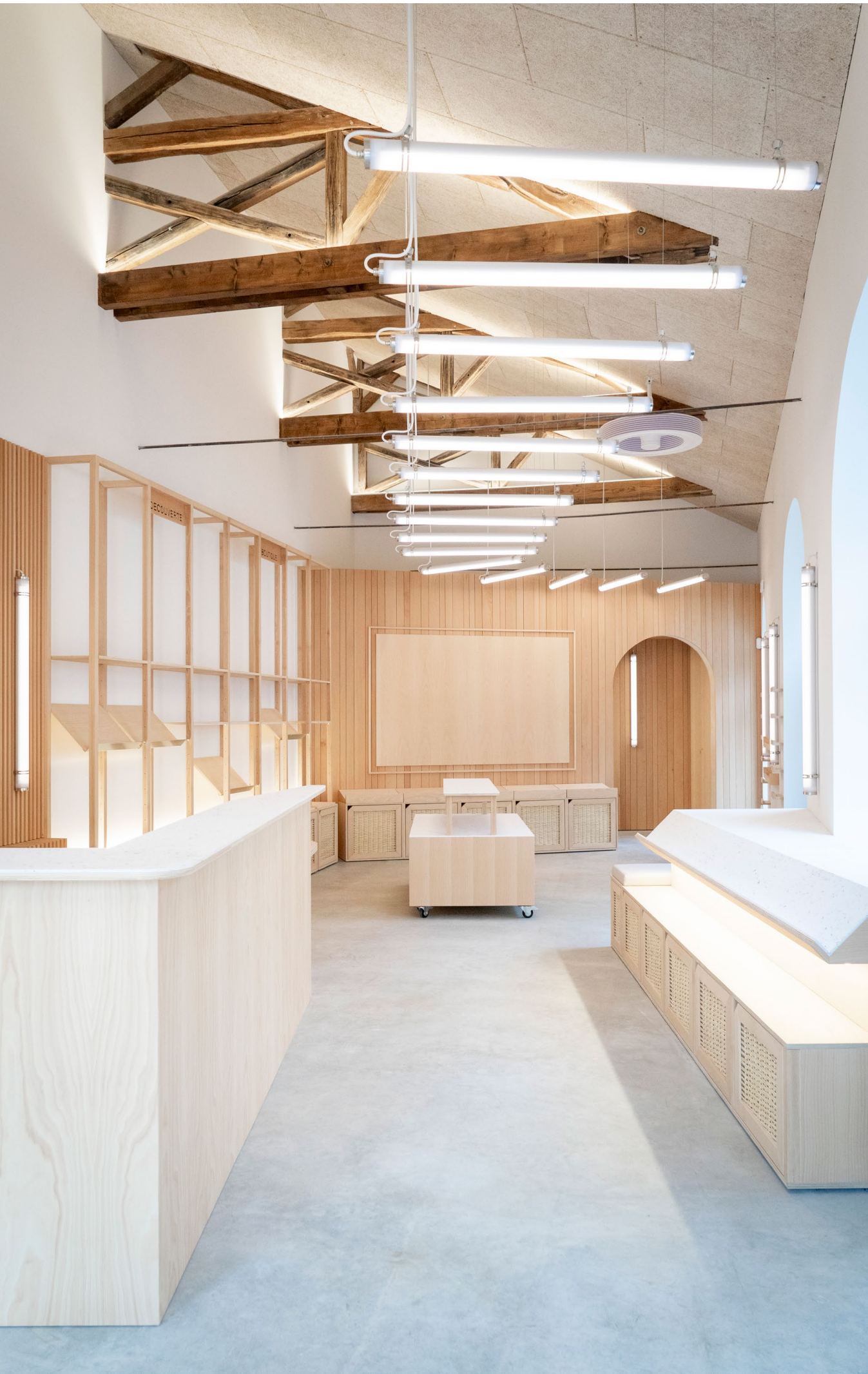
La charpente des anciennes écuries est reprise avec des poutres réemployées.
