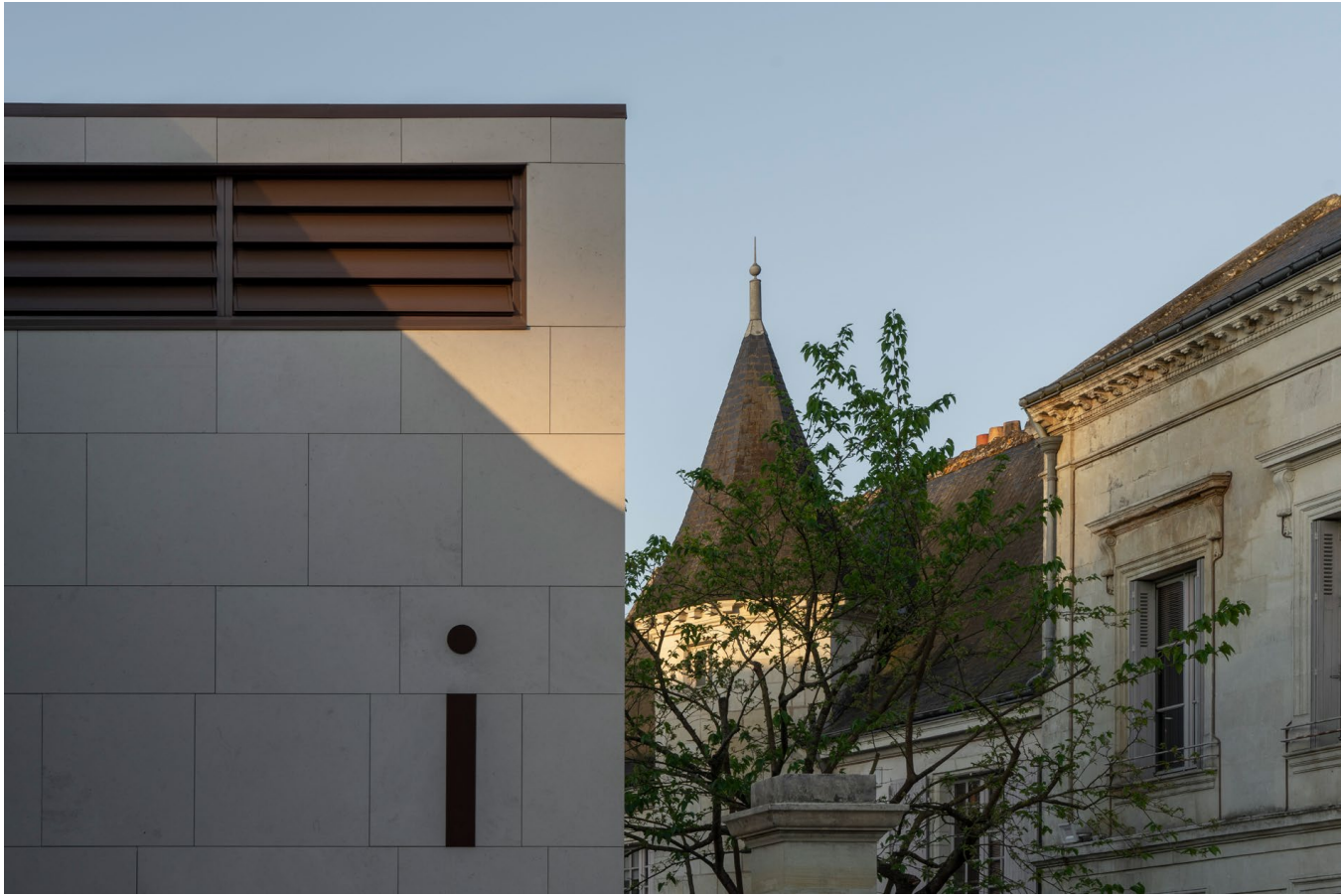
La pierre agrafée en façade est le fruit des discussions avec l'Architecte des Bâtiments de France.
