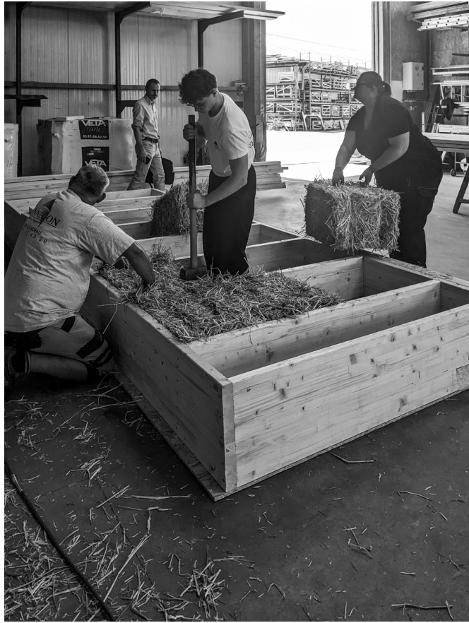
Fabrication des caissons bois-paille chez Sennegon, charpentier à Azay-Le-Rideau.
