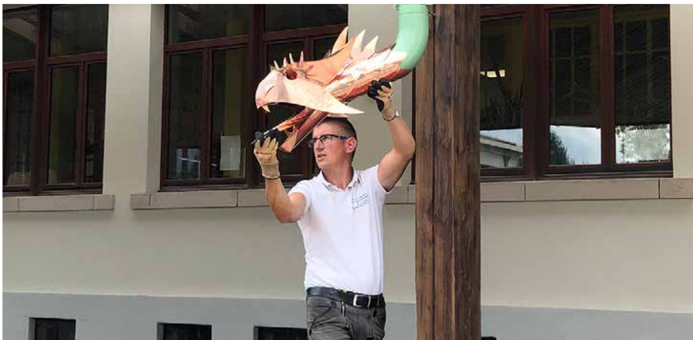
Installation de la tête de dragon.
