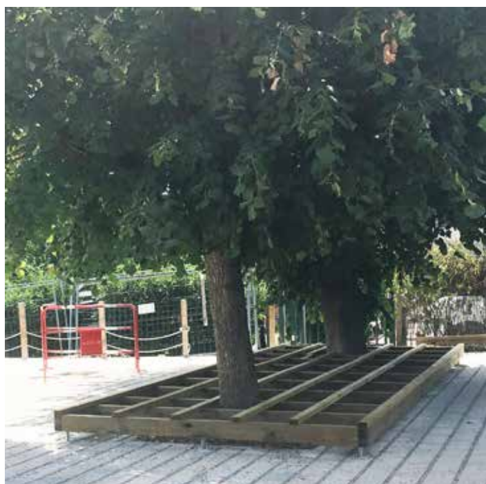
La fosses des tilleuls est agrandie, amendée en compost et en paillage avant la mise en œuvre du platelage bois.
