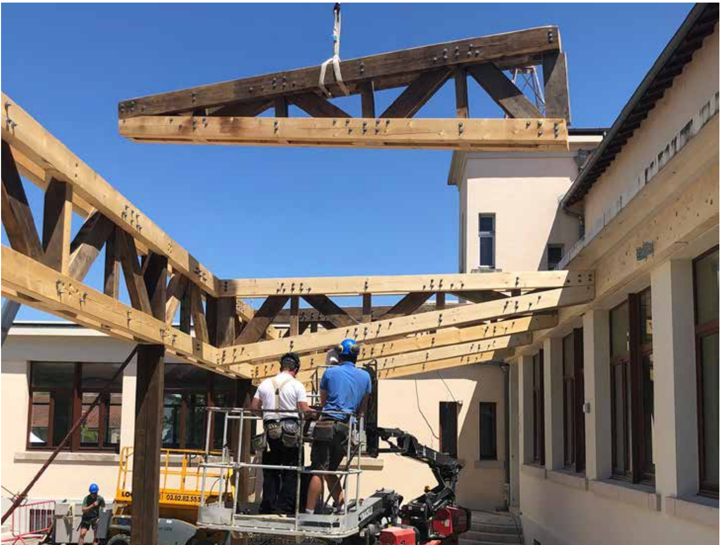
Pose de la charpente de réemploi préassemblée.
