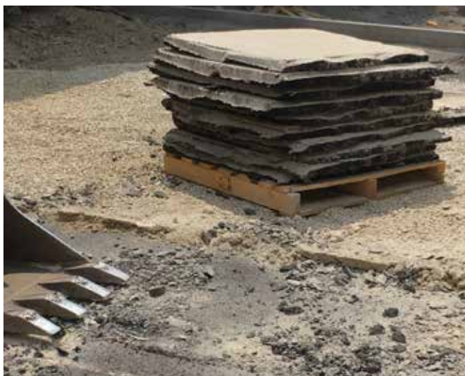
Les dalles d'enrobés sont prélevées dans la cour, stockées sur palettes, puis réemployées pour créer un muret d'assise et de soutènement de part et d'autre du tunnel.
