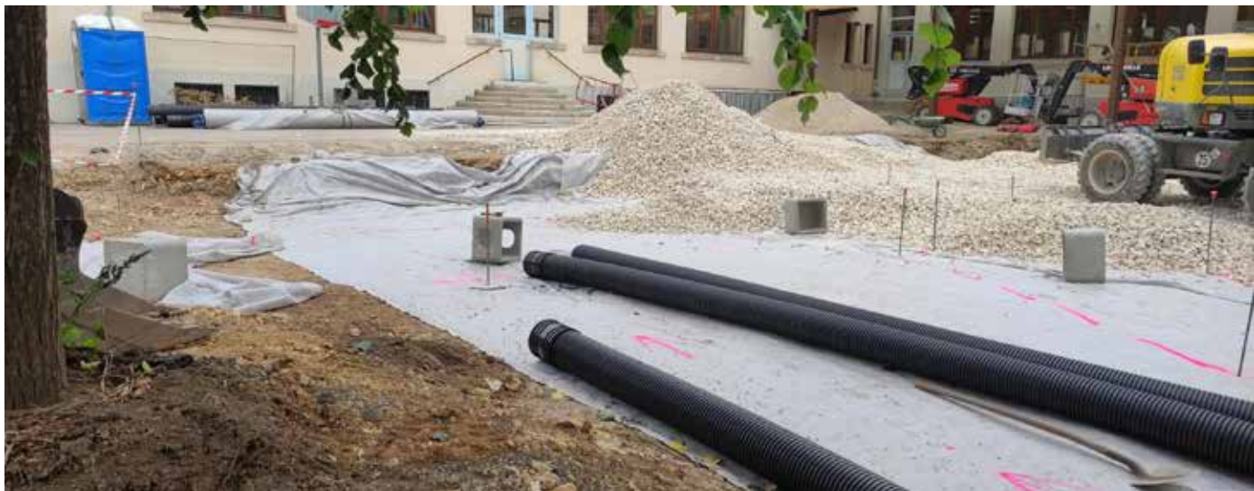
Mise en œuvre de la structure drainante constituée de granulats calcaires 60/80 mm sur 60 cm d'épaisseur.
