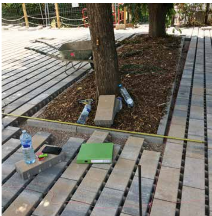
La fosses des tilleuls est agrandie, amendée en compost et en paillage avant la mise en œuvre du platelage bois.
