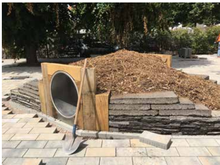
Les dalles d'enrobés sont prélevées dans la cour, stockées sur palettes, puis réemployées pour créer un muret d'assise et de soutènement de part et d'autre du tunnel.
