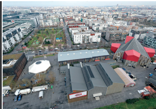
Des installations vouées à être temporaires
