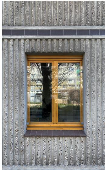
*Isolation thermique par l'extérieur partielle, rénovation des bétons et nouvelles fenêtres bois.*
