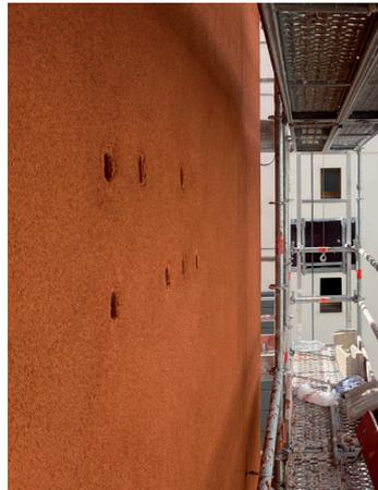
*Des nichoirs à moineaux sont intégrés dans l'isolation thermique.*
