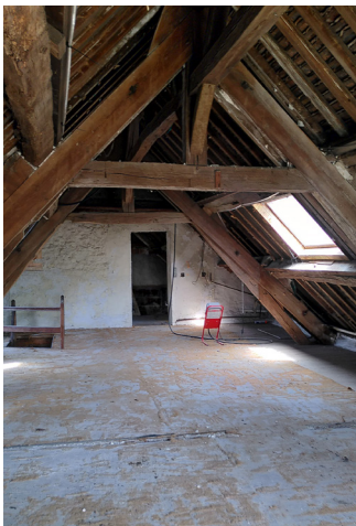
Plancher bois conservé, rénovation par ponçage finition vernis
