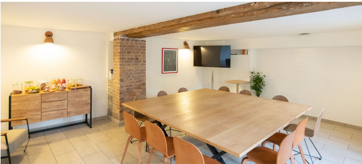
Blocs de chaux-chaivre en doublage des murs enterrés, finition enduit à la chaux ci-dessous : rendu final des doublages en blocs de chaux-chaivre.
