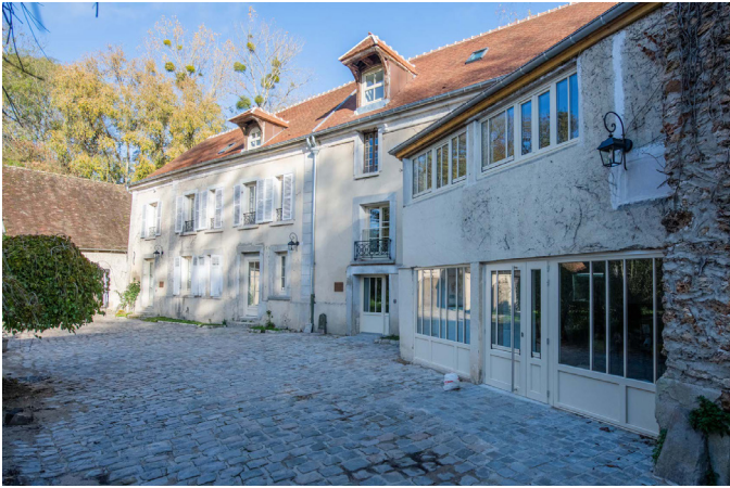
Façade sur cour du bâtiment B
