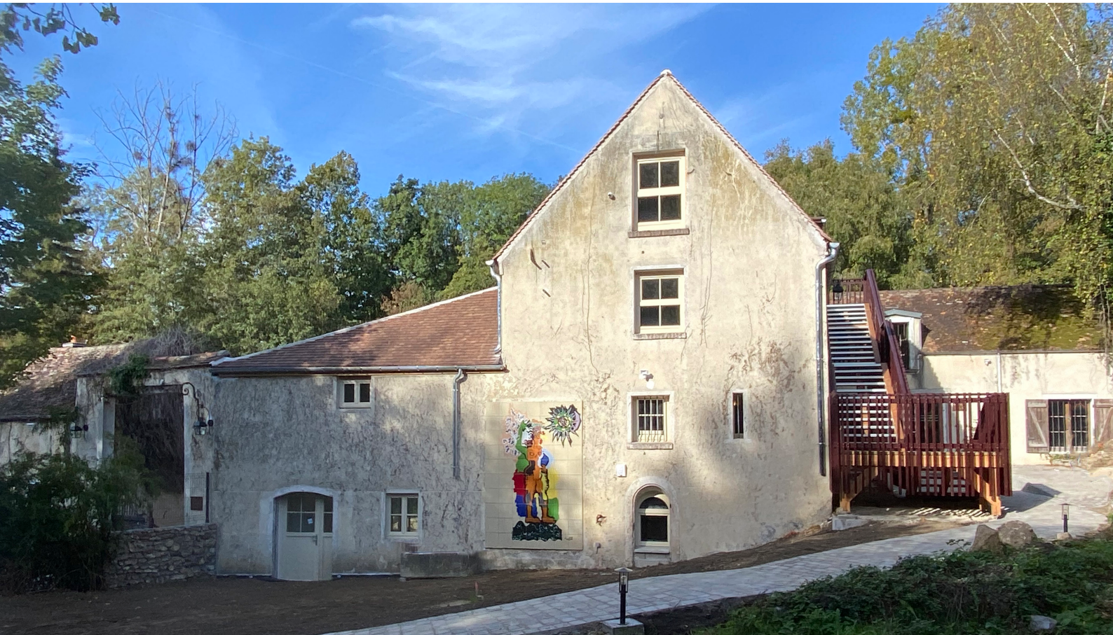
Façade sud du bâtiment B, l'intervention extérieure majeure est l'adjonction d'un escalier de bois rouge sur pieux vissés, à droite
