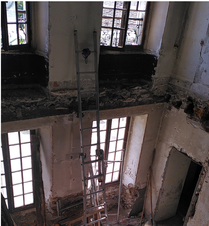
Démolition de plancher pour construction à neuf
