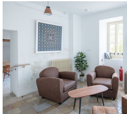
Mur de refend avec retour de doublage traitant les ponts thermiques
