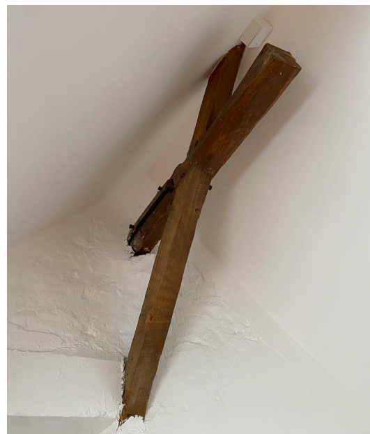
Éléments de charpente coupé maintenu
