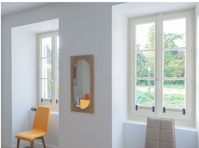
Fenêtres équipées de réglottes de ventilation à réglage manuel
