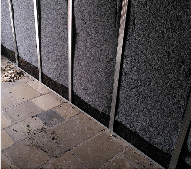
Pied d'isolation intérieure en liège expansé, partie courante en coton recyclé Métisse
