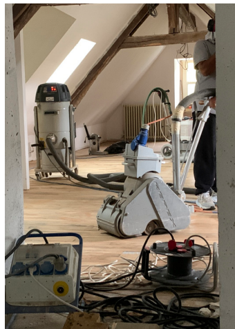
Plancher bois conservé, rénovation par ponçage finition vernis
