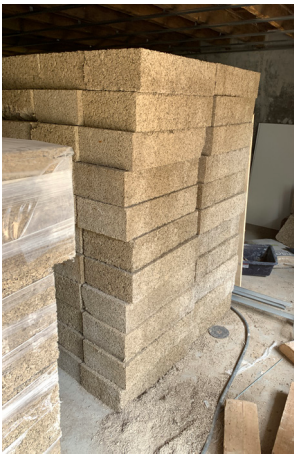
Blocs de chaux-chaivre en doublage des murs enterrés, finition enduit à la chaux ci-dessous : rendu final des doublages en blocs de chaux-chaivre.
