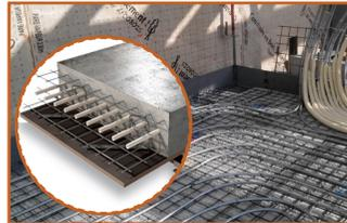
Le projet met en œuvre un concept low tech : Le bâtiment réduit les besoins en énergie avec dalle active dans les ateliers et les bureaux dont la source est la géothermie verticale (photo & illustration : réseau dans les dallages & planchers)
