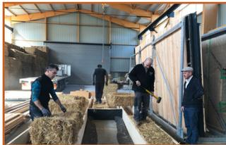
Le projet frugal privilégie les matériaux biosourcés ou géo-sourcés : 3000 bottes de pailles pour isoler le bâtiment provenance à 30km du chantier. (photo mise en oeuvre de la paille dans les caissons bois)
