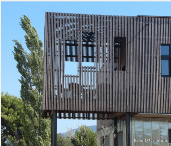
Terrasse sur pilotis
