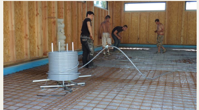
Activation béton avec tube type PCBT
