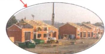
Les logements seront construits en briques monmur, avec une isolation thermique par l'extérieur, ainsi que des PAC air/eau pour le chauffage et panneaux solaires pour l'ECS
