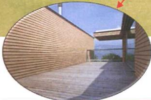
Isolation par l'extérieur de 195mm, pour une résistance de 5,7m<sup>2</sup>.K/W, avec bardage bois en façade.
