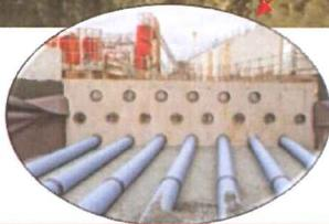
Le puits climatique est raccordé aux CTA des salles de classe et bureau. Permet de rafraîchir l'air neuf ou bien de le réchauffer, respectivement en été et en hiver.
