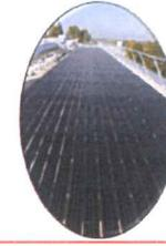
50m<sup>2</sup> de capteurs solaires thermiques raccordés à une PAC (type HélioPac) produiront l'ECS pour hébergement.
