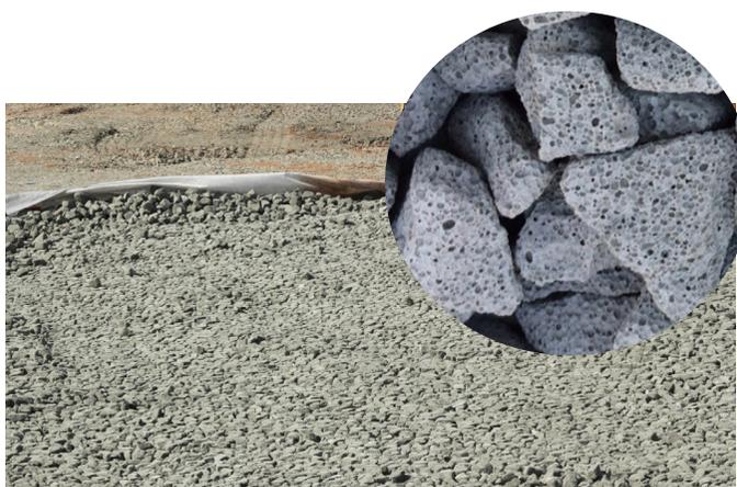
Chaque maison est construite avec des fondations sur radier et un isolant constitué de verre cellulaire MISAPOR. un matériaux léger, avec grande résistance à la compression et performant au niveau du drainage et une pose rapide.
